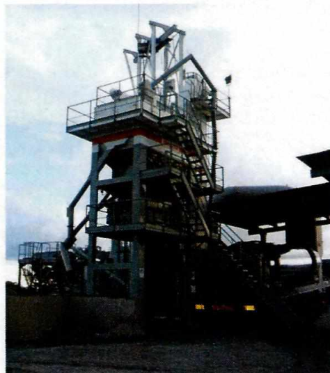
Figura 9.4 Planta Asfáltica Murcia y Murcia S.A
