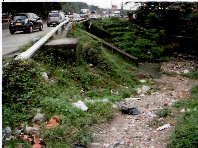
Figura 8.1 Características geomorfológicas del cauce del Caño Grande, aguas abajo del sitio del puente actual.
