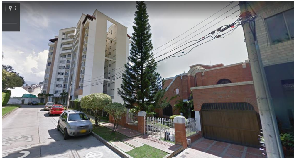
Figura 39. Calle 29: vía posterior del predio
