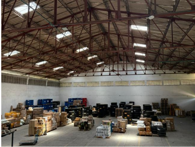
Figura 1. Área de almacenamiento de mercancía.
