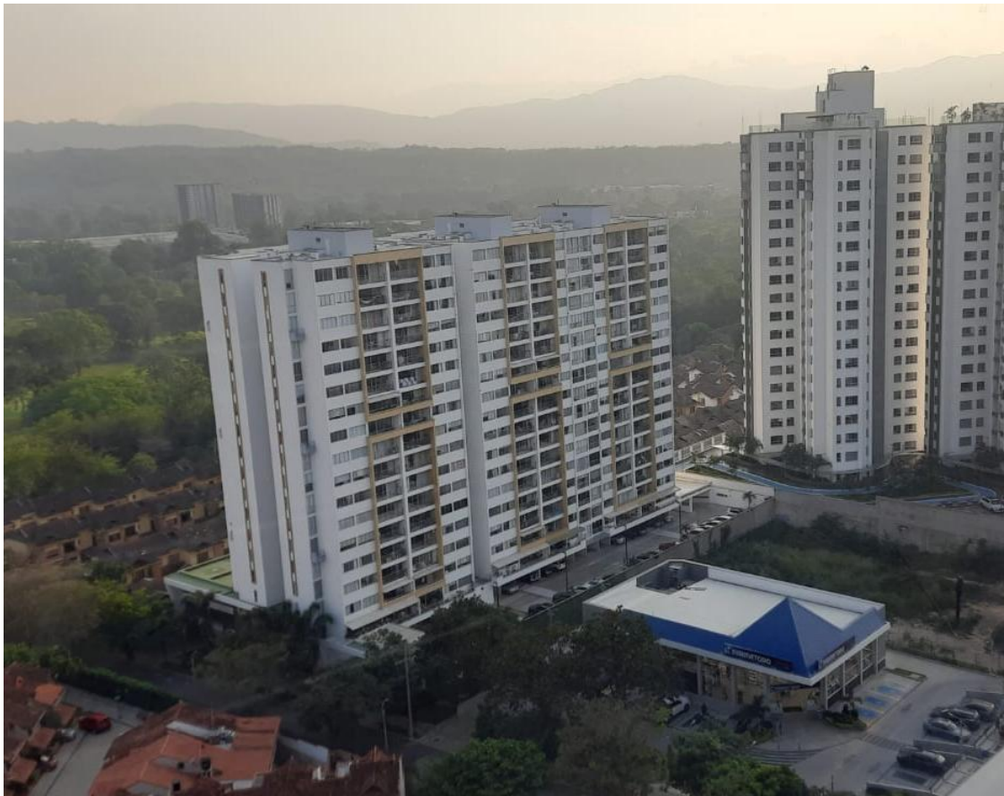
Figura 30. Estado actual del lote 3
