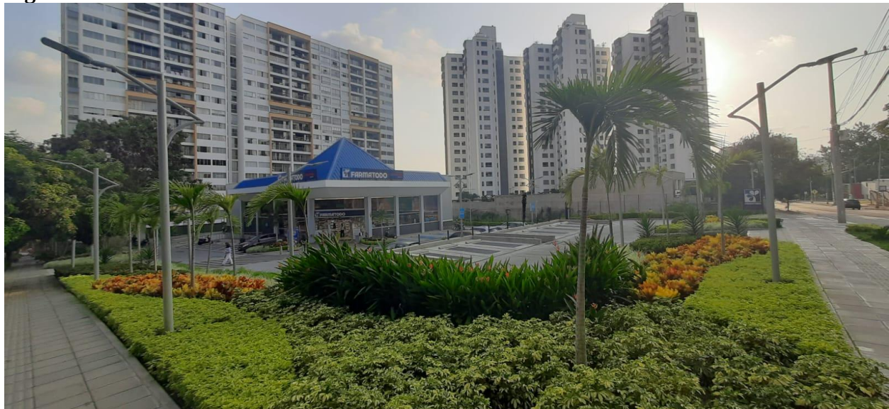
Figura 28. Estado actual del lote
