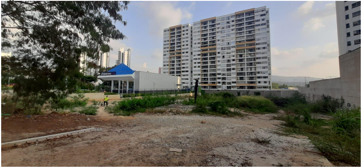
Figura 29. Estado actual del lote 2
