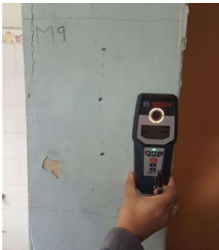
Fotografía 5. Detección magnética de armaduras Fuente: BRV S.A.S
