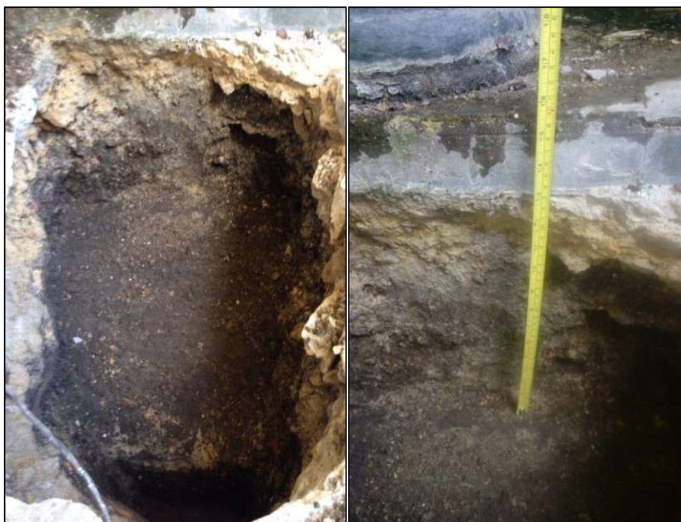
Fotografía 4. Apique de auscultación Fuente: BRV S.A.S.
