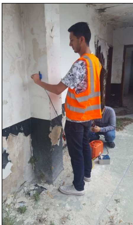
Fotografía 7. Realización prueba de ultrasonido Fuente: BRV S.A.S
