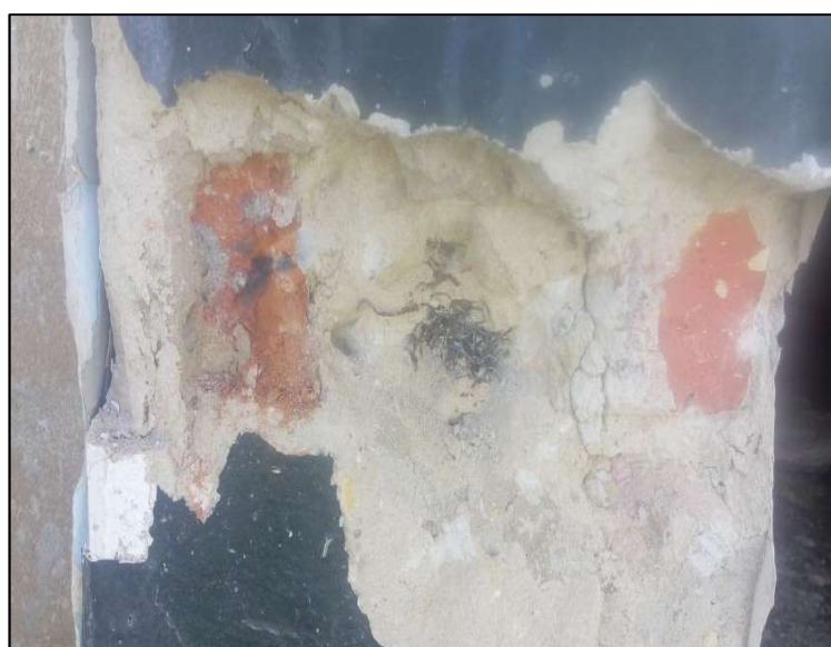
Fotografía 6. Realización de regatas en columnas Fuente: BRV S.A.S
