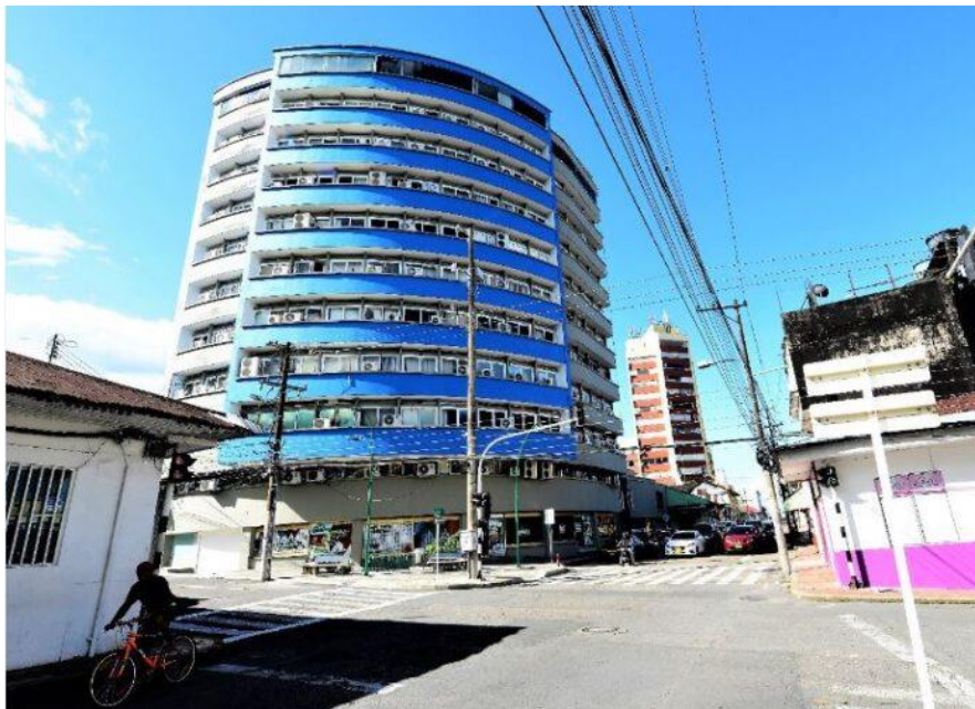
Figura 1. Vista frontal Edificio Alcaldía Municipal.
