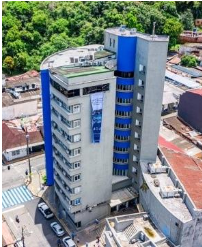
Figura 2. Vista lateral Edificio Alcaldía Municipal.
