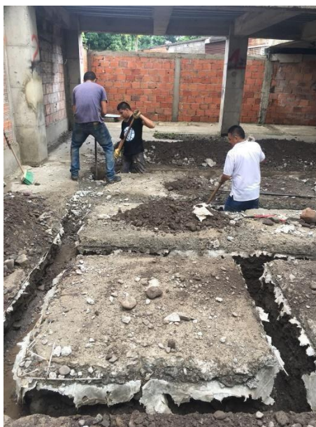
Figura 55 Excavaciones de Zanjas para instalación de Acometidas
