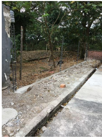
Figura 31 Vaciado del Concreto
