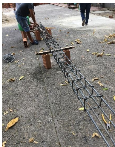
Figura 30 Amarrado de Hierro Para vigas y Columnas
