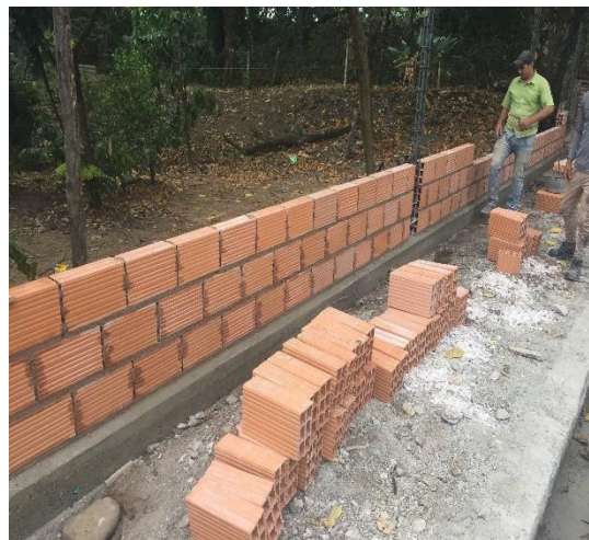
Figura 34 Levantamiento Muro en Mampostería
