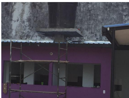
Figura 49 Adecuación del Tanque Elevado
