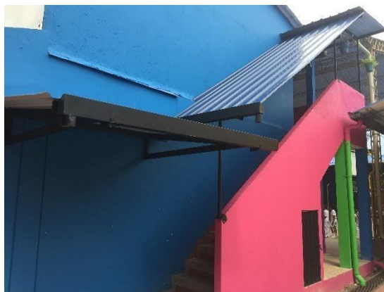
Figura 26 Suministro e Instalación del Domo
