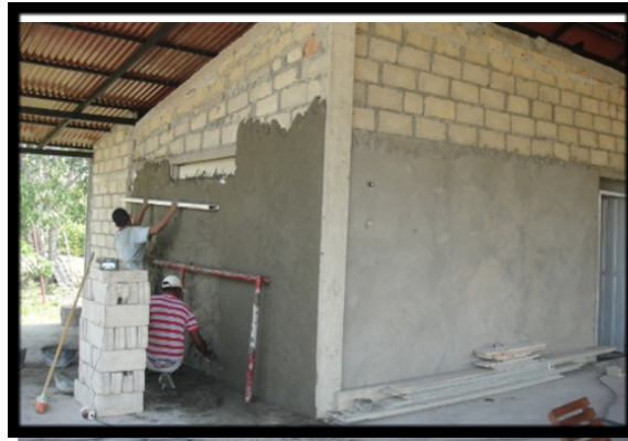
Figura 4 Mampostería y mortero pañete
