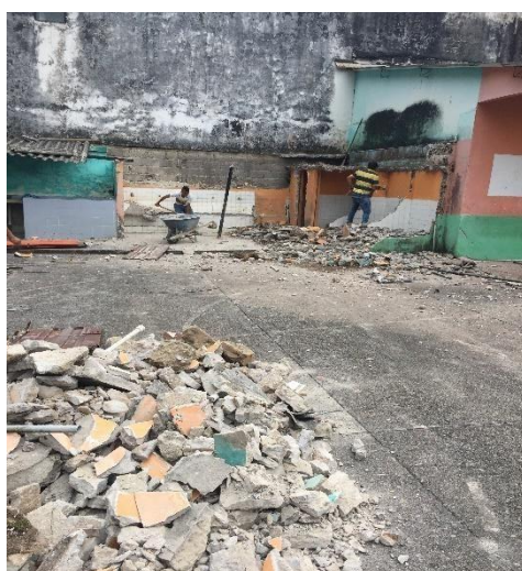
Figura 28 Demolición de las Unidades Sanitarias
