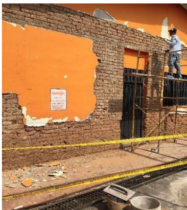
Figura 17 Proceso Constructivo de la Instalación del Pañete
