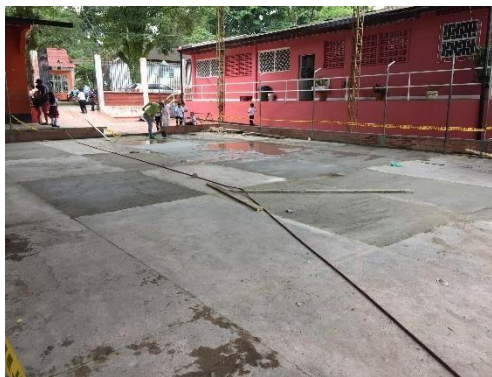
Figura 21 Terminación e hidratación de la placa de contra piso.
