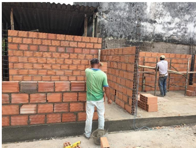
Figura 41 Muros Divisorias en Mampostería
