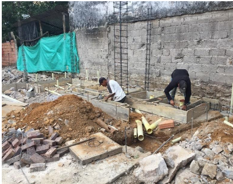
Figura 37 Formaleta para el vaciado del concreto
