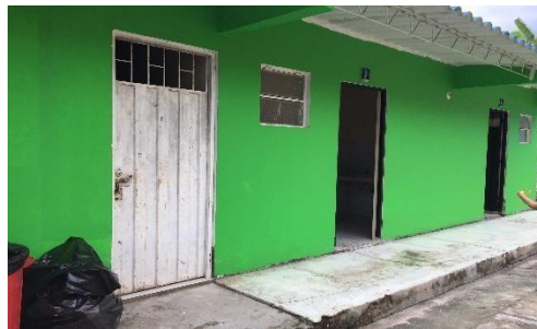
Figura 15 Pintura Exterior e Interior del Baño
