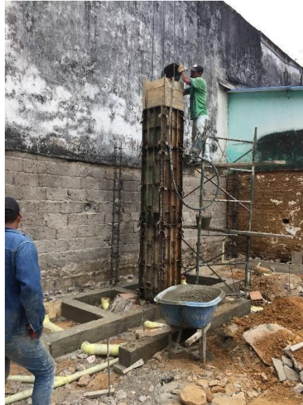
Figura 38 Vaciado del Concreto
