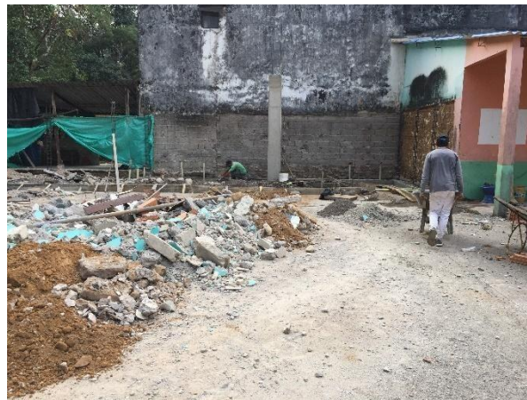
Figura 39 Retiro de Formaleta Columna Central
