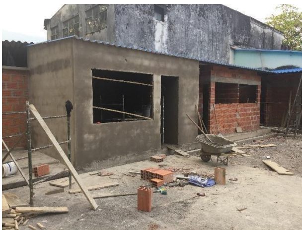
Figura 44 Pañete Muro Unidades Sanitarias
