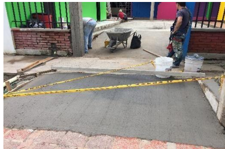
Figura 23 Acabados de la Ampliación en la Entrada
