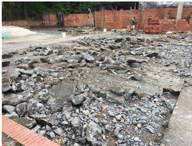
Figura 43 Demolición Placa Contrapiso Parque de Diversiones
