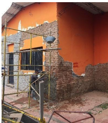
Figura 18 Proceso Constructivo de la Instalación del Pañete
