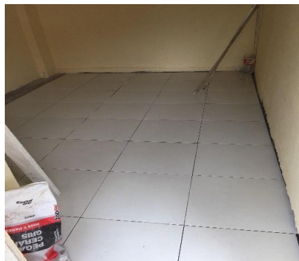
Figura 13 Piso en Cerámica Liso .20x.20
