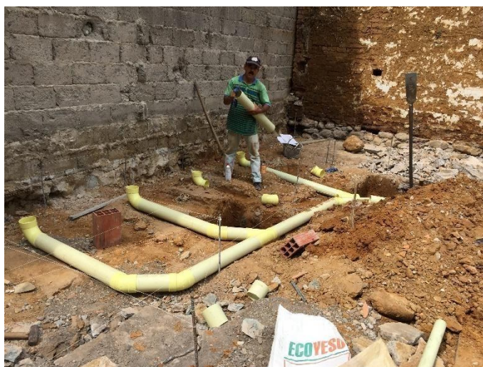
Figura 35 Instalación Tubería Sanitaria
