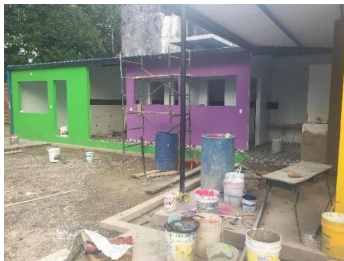
Figura 48 Pintado Exterior e Interior Unidades Sanitarias
