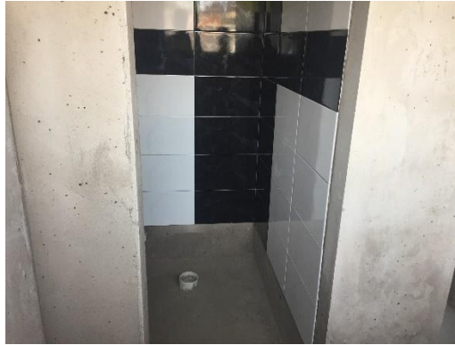
Figura 46 Instalación del Enchape
