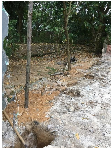
Figura 29 Excavación en conglomerado seco
