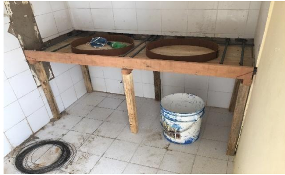
Figura 14 Formaleta para Mesón de Lavamanos
