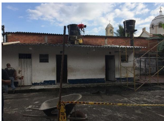
Figura 12 Lavado General de la Cubierta
