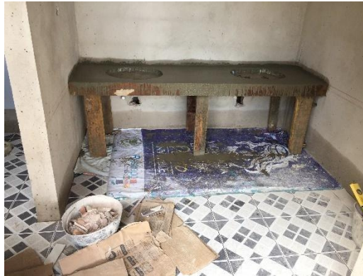
Figura 47 Adecuación de los lavamanos
