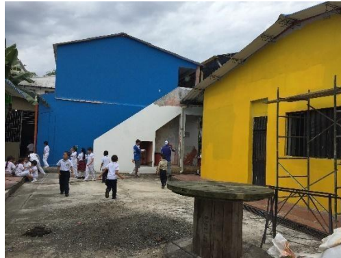
Figura 19 Pintura Exterior e Interior de la Institución
