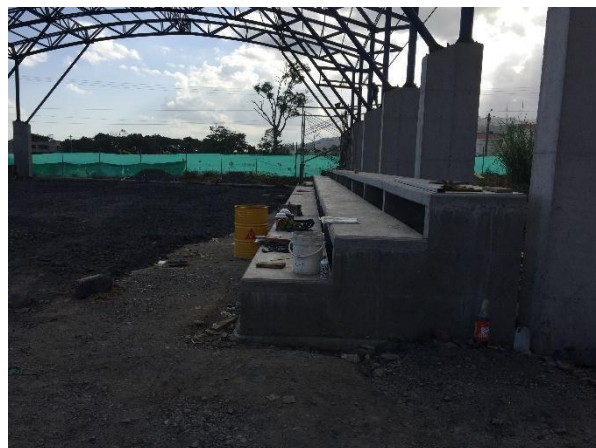
Figura 61 Construcción del Polideportivo en el Mega Colegio
