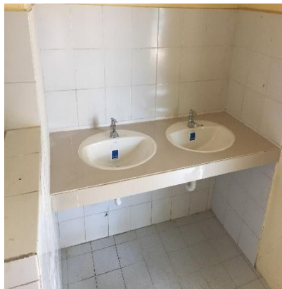
Figura 16 Adecuación de Lavamanos
