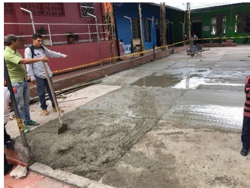
Figura 20 Vaciado del Concreto
