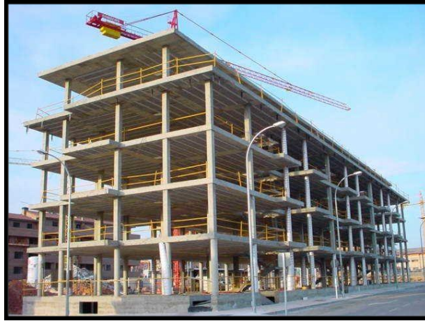
Figura 1 Ejemplo de Estructuras en concreto reforzado.
