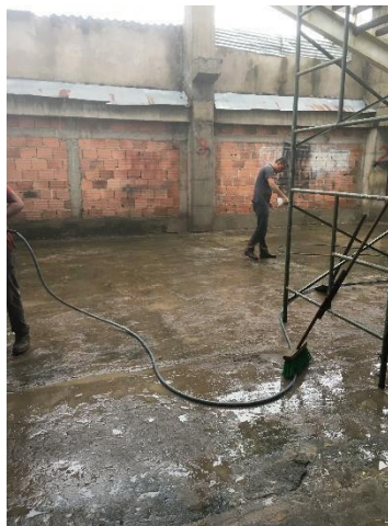
Figura 53 Limpieza del Edificio
