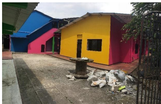
Figura 25 Culminación de la Obra en la Sede Principal
