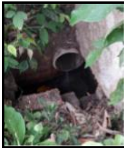
Ilustración 10: Zona de vertimiento El Mirador Fuente: PSMV Inspección San Javier, Municipio de La Mesa, Cundinamarca.2016
