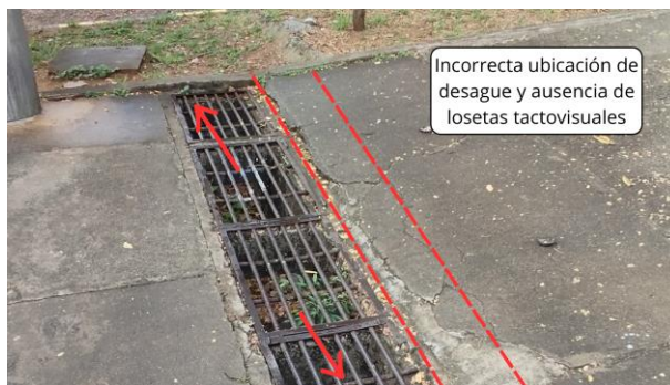
Figura 5. Salida parqueaderos piscinas
