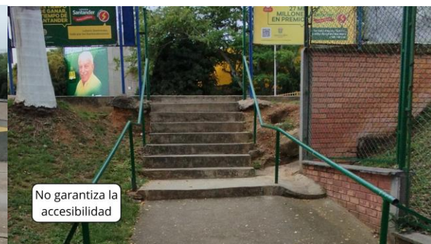
Figura 4. Salida peatonal piscinas
