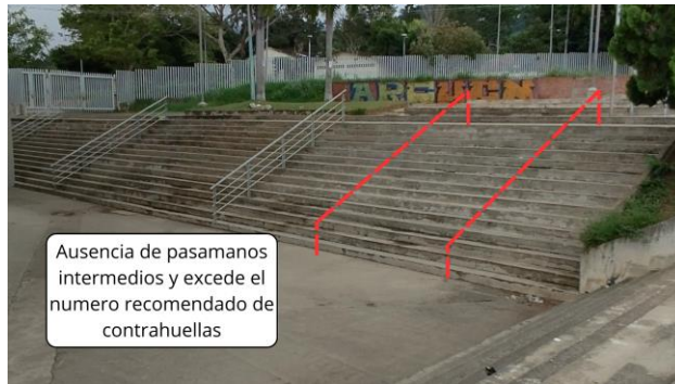
Figura 13. Plazoleta Coliseo Bicentenario
