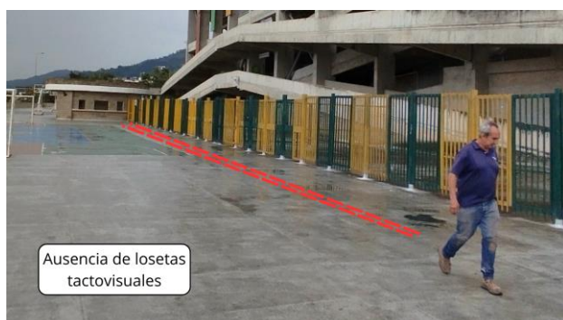
Figura 23. Ausencia losetas tacto visuales
