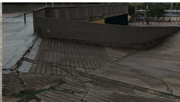
Figura 6. Rampa acceso Villa Olímpica
