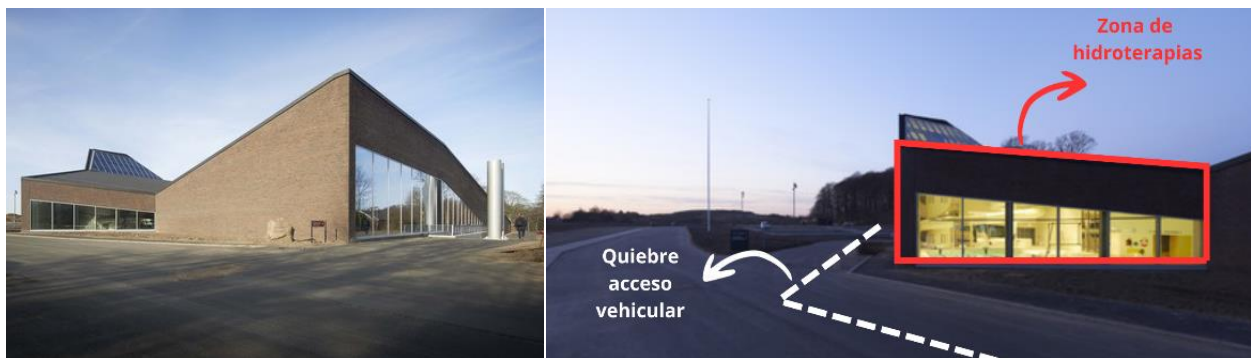
Figura 26. Fotografía fachada principal Centro de Rehabilitación Vandhalla
