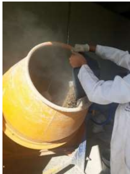
Ilustración 8 Proceso de mezclado en la hormigonera Fuente: Autores
