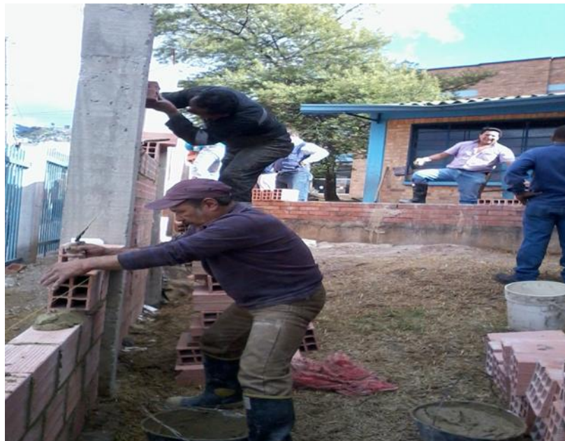
Trazado y levantamiento de muros en manposteria.
