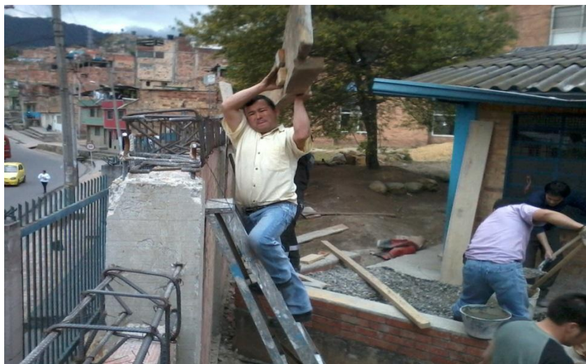
Amarre y encofrado de viga de corona (amarre).
