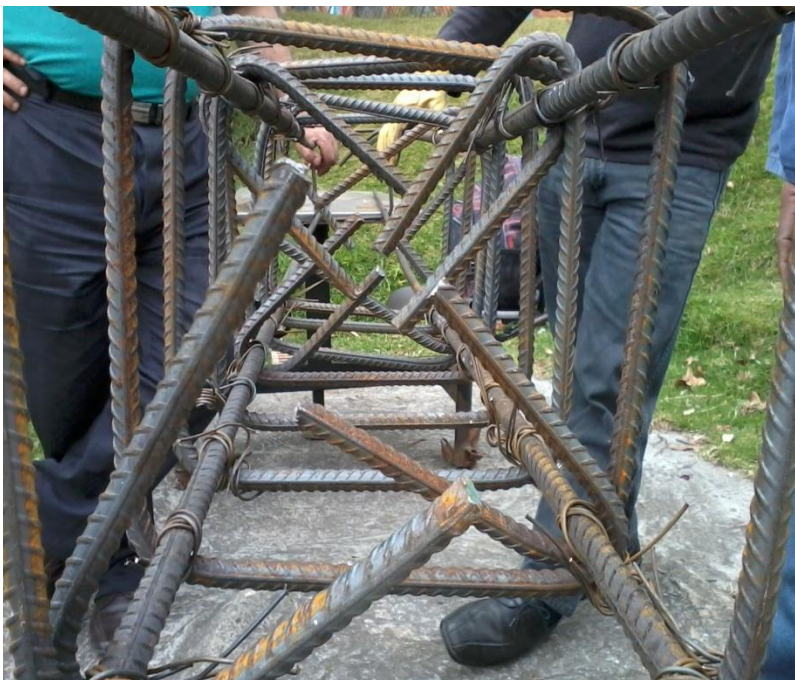
Dentro de la practica se trabajo en el figurado y armado de las armaduras de acero.
