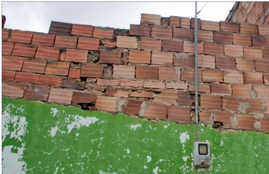
Irregularidad, combinación y pésima calidad de los mampuestos.
