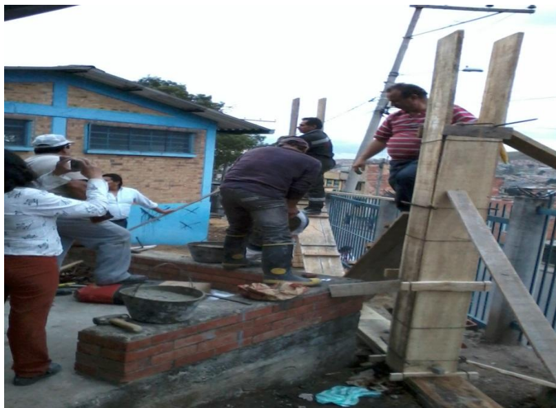
Encofrado y fundicion de las columnas en concreto(hormigon)
