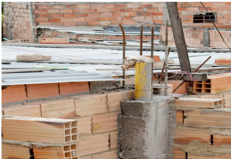
Instalacion de tuberias dentro de las columnas.
