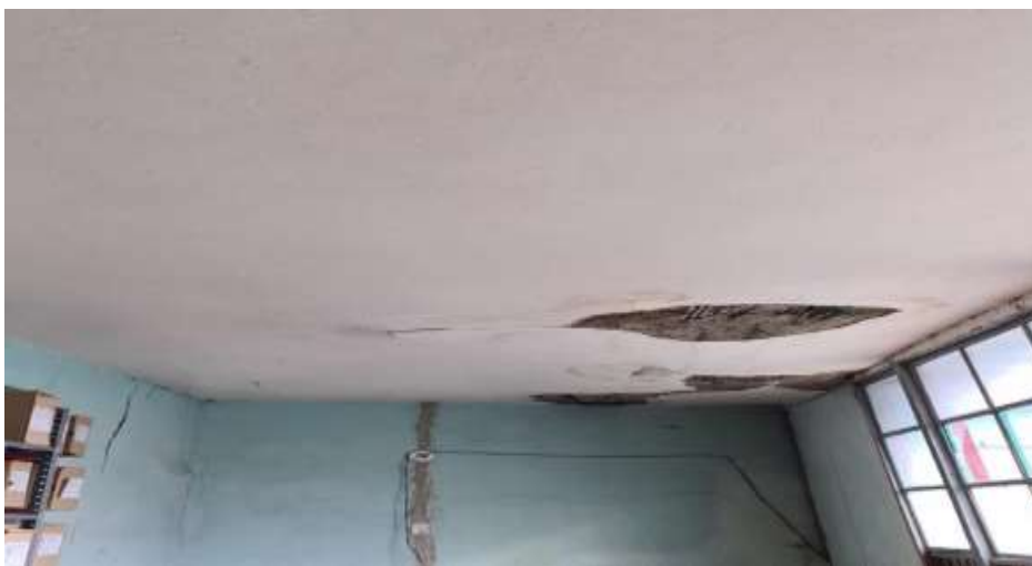
Figura 20 Cielo raso archivo municipal
