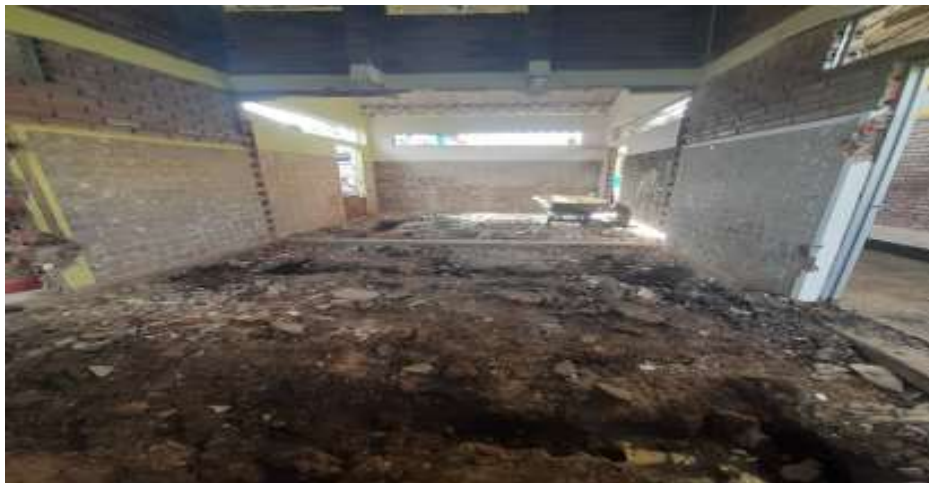
Figura 9 Demoliciones batería sanitaria escuela urbana
