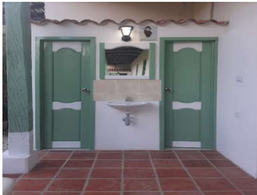
Figura 24 Remodelación unidades sanitarias teatro de Boyacá
