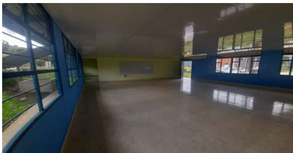
Figura 29 rehabilitación Escuela antigua Palchacual centro
