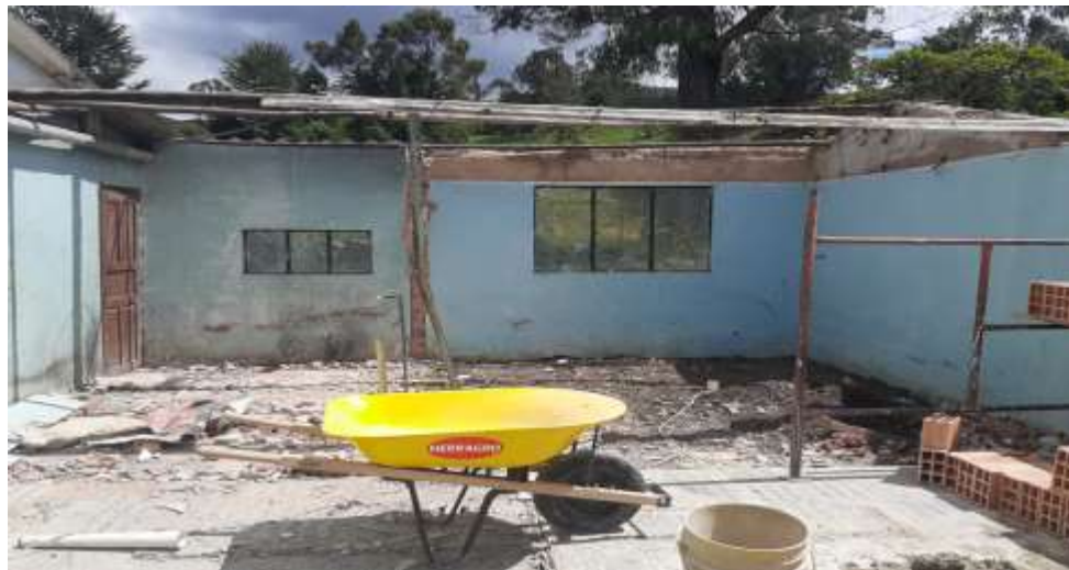
Figura 27 Demoliciones Escuela antigua Palchacual centro
