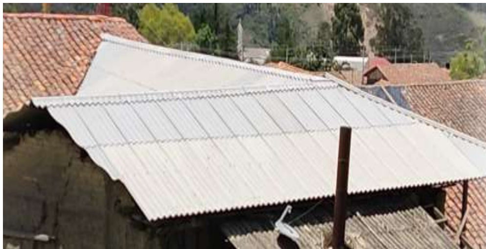
Figura 22 Mantenimiento tejado archivo municipal
