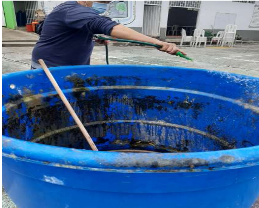
Figura 15 Tanque de reserva colegio de el Cardón
