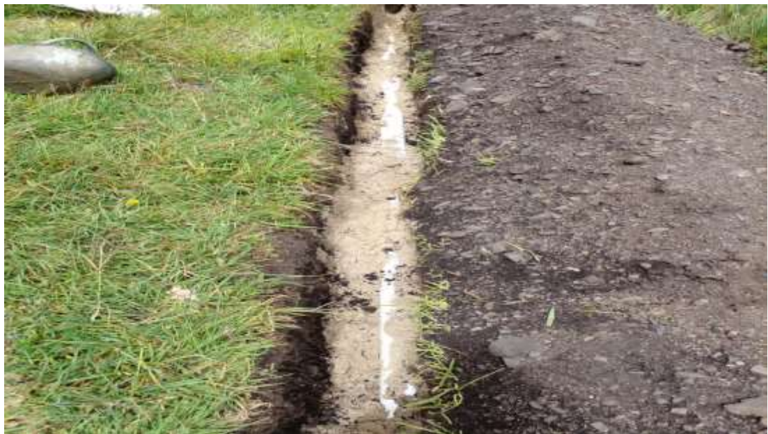
Figura 6 suministro e instalación tubería pvc. d = 3" rde 21 unión mecánica
