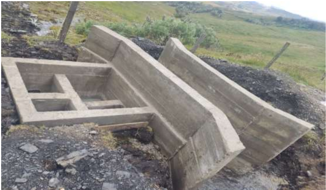
Figura 4 Bocatoma acueducto el mortiño
