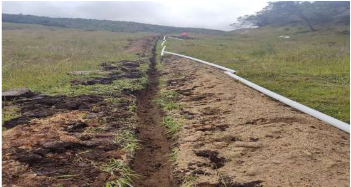
Figura 5 Excavación red de conducción
