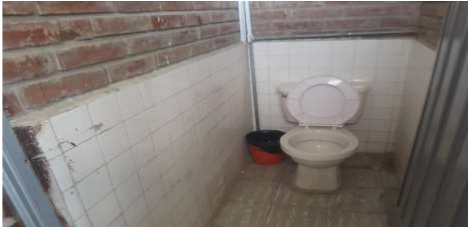
Figura 8 Sanitarios escuela urbana
