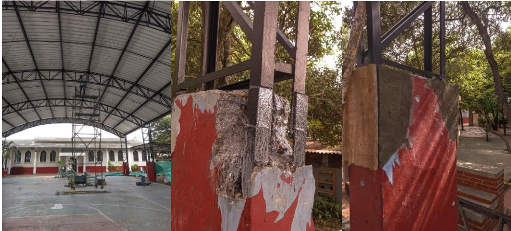
Figura 4. Cubierta metálica / Columnas
