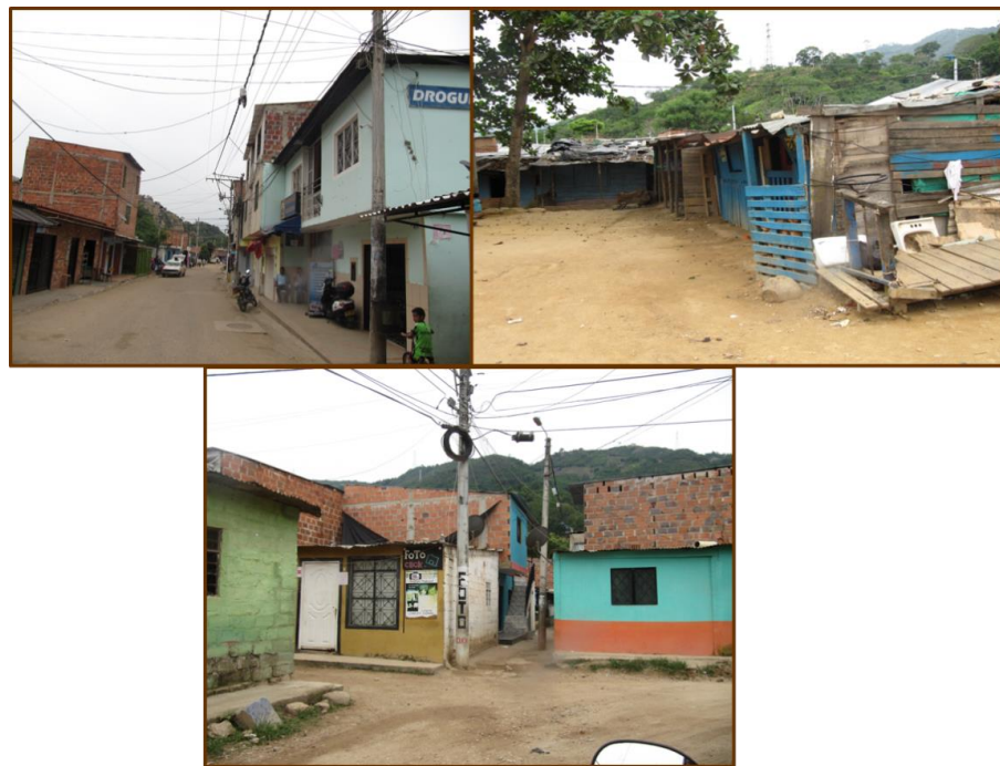
Figura 42. Registro fotográfico asentamientos informales, lado izq. asentamiento Galán, lado der. Asentamiento 5 de Enero, lado inferior asentamiento Pizarro.
