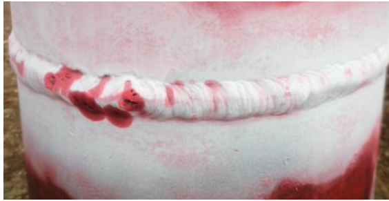
Ilustración 19 Líquidos Penetrantes toma 2
