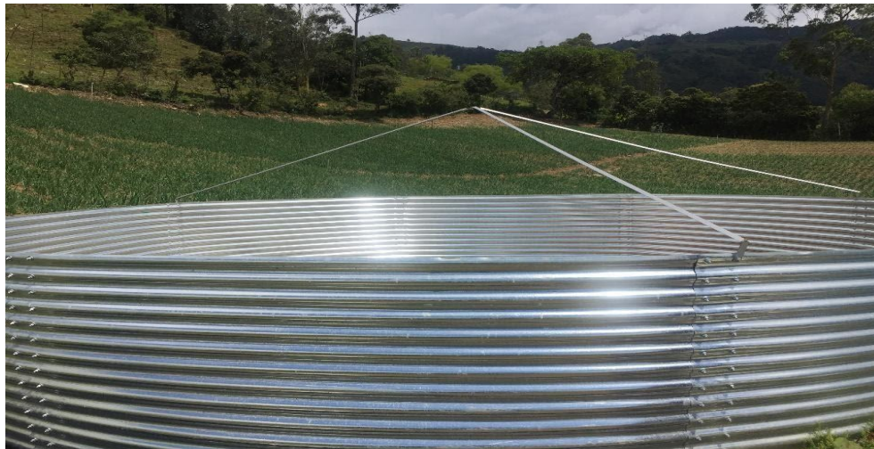
Figura 24. Almacenamiento agua lluvia.
