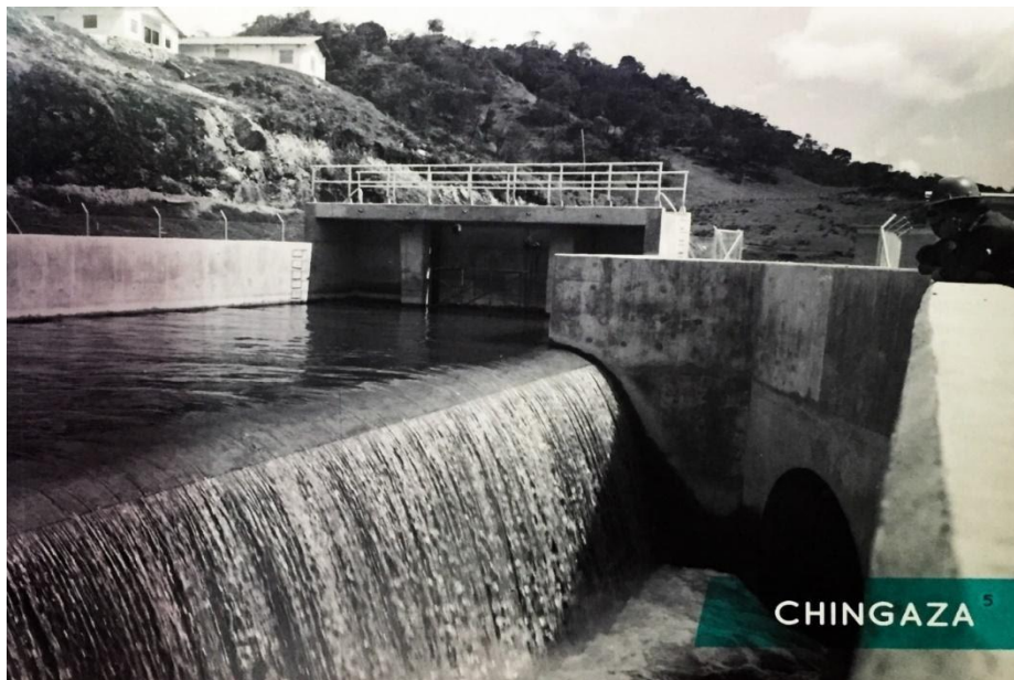
Figura 16. Planta de tratamiento del agua en Chingaza.
