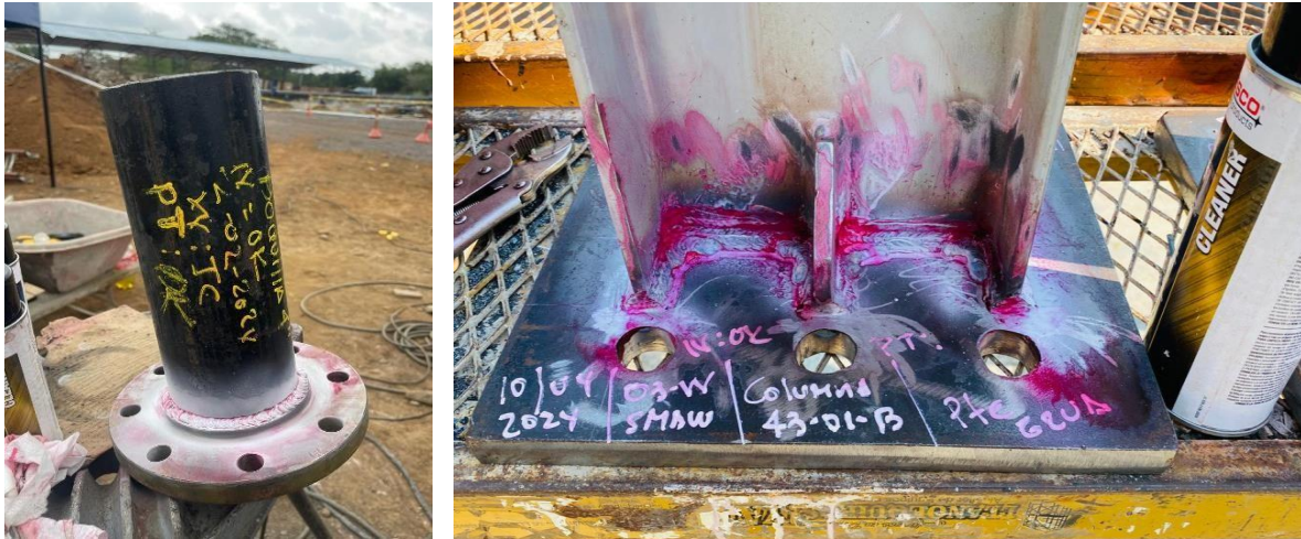
Figura 18. Inspección de soldadura con tintas penetrantes.
