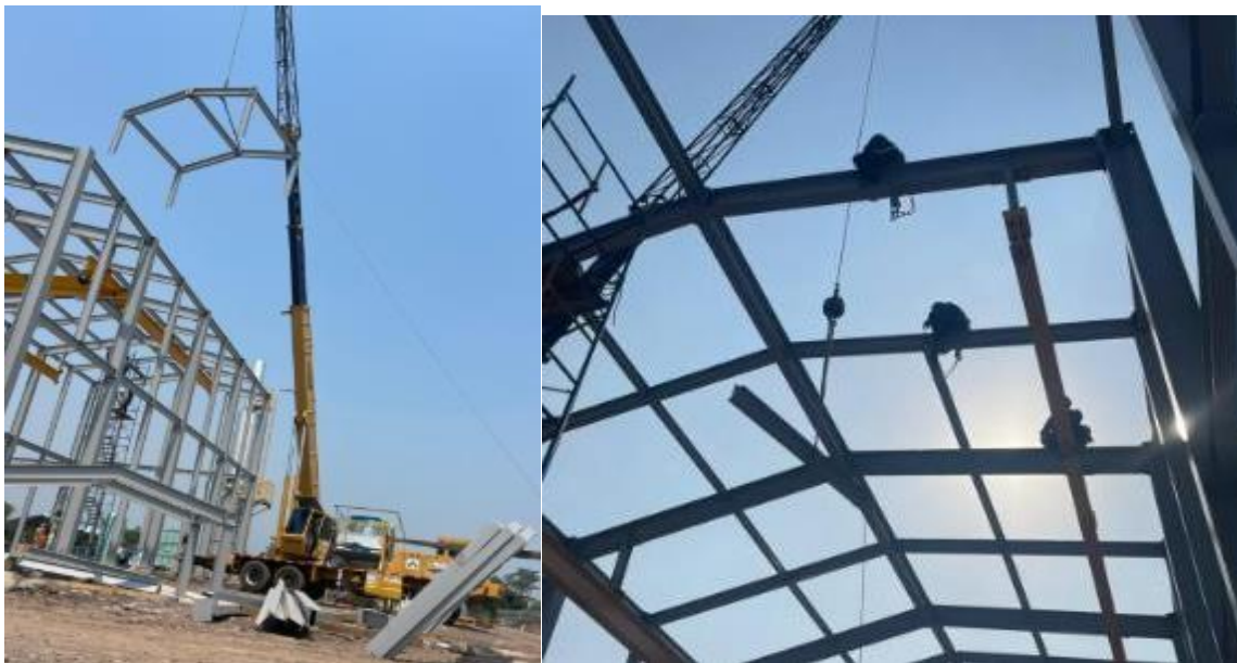
Anexo UU. Supervisión de instalación estructura metálica power house.
