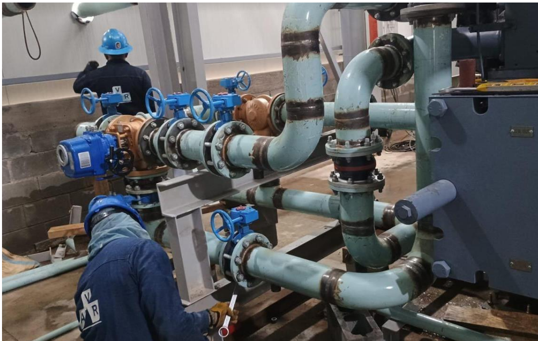
Anexo XX. Supervisión de conexiones de tuberías
