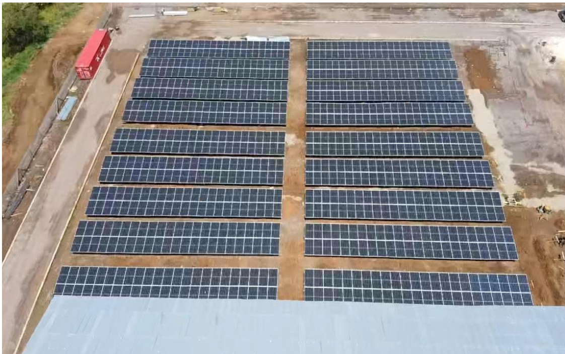
Figura 11. Montaje de paneles solares (24 de 40 módulos).
