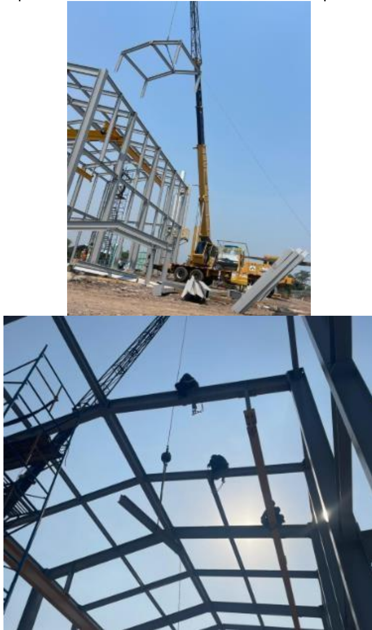
Figura 14. Supervisión de instalación estructura metálica power house.
