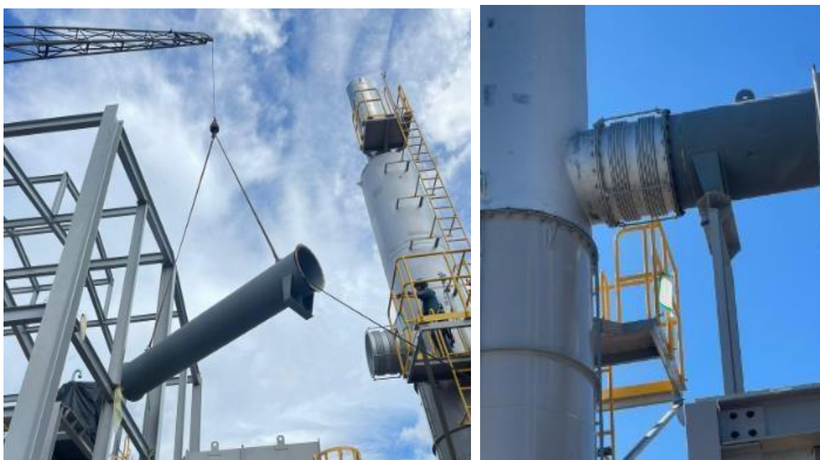
Figura 20. Instalación de ducto de escape del motor.
