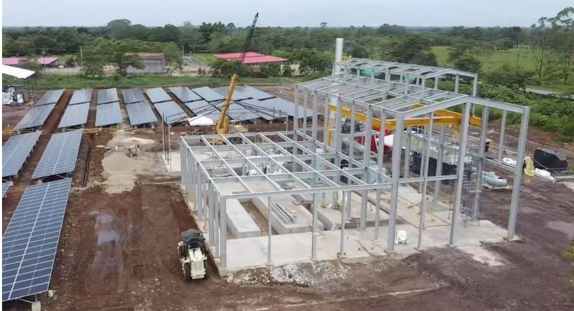
Figura 12. Estructura metálica de la Power House y la Workshop.
