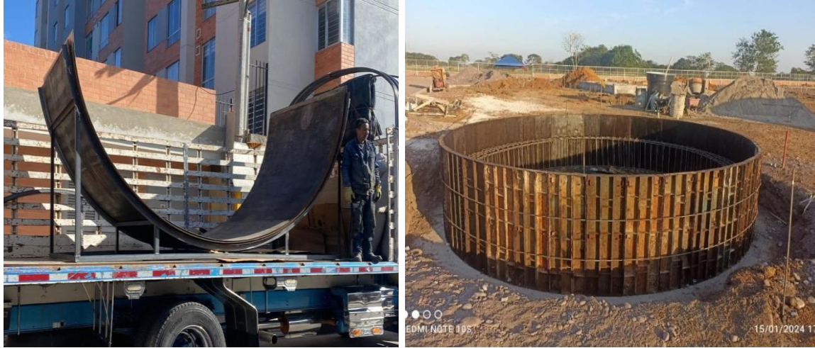
Figura 7. Estructura de soporte de los tanques.
