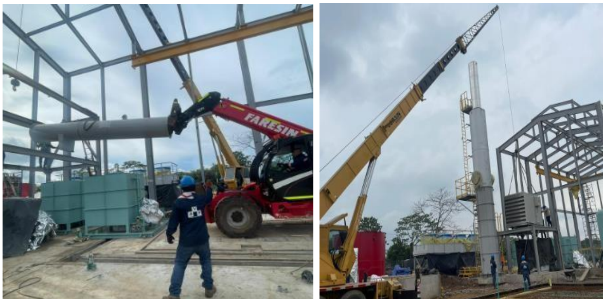
Figura 21. Instalación del ducto de admisión y ventilador principal.
