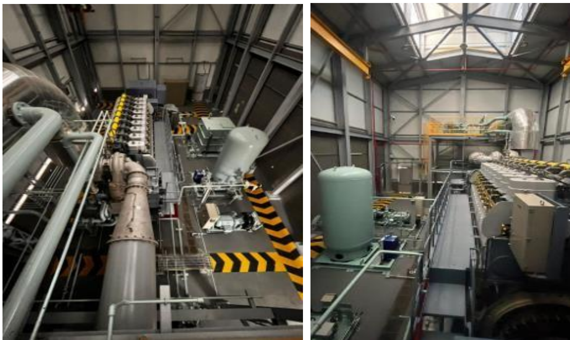
Figura 25. Cuarto de máquinas finalizado.
