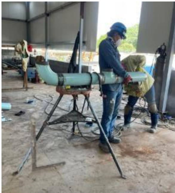
Figura 15. Soldadura de tubería con técnica GTAW.
