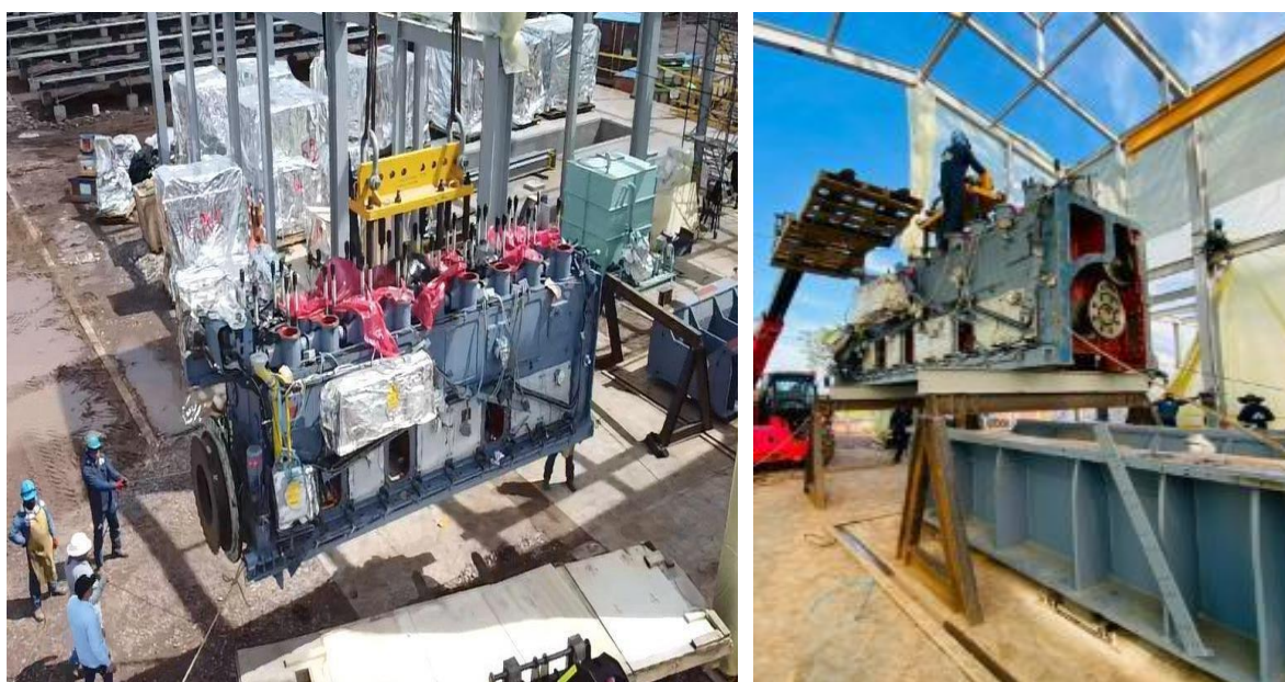
Figura 22. Instalación del bloque del motor.
