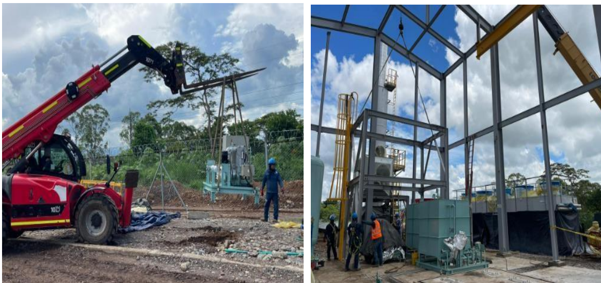
Figura 19. Instalación de equipos auxiliares.
