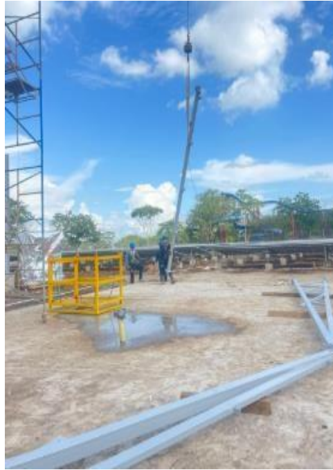
Figura 13. Supervisión de instalación estructura metálica workshop.
