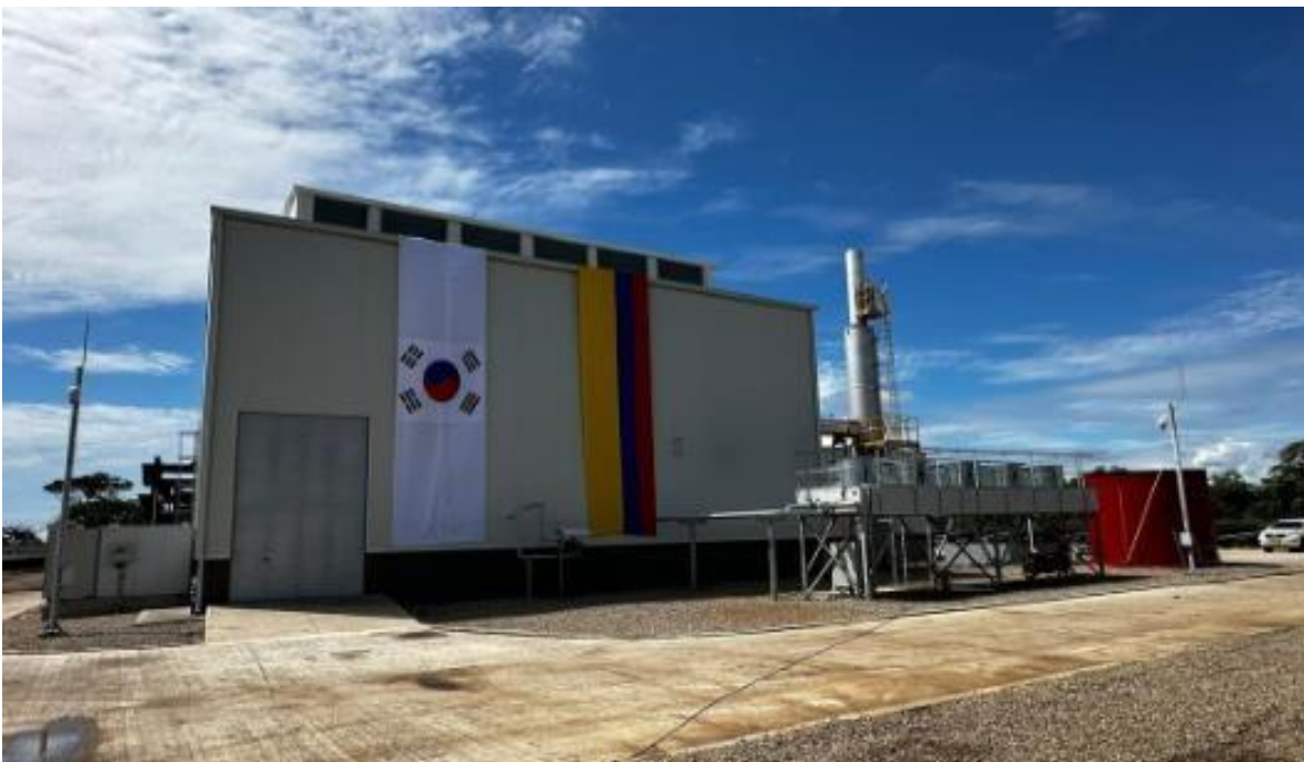
Figura 28. Power House finalizada.
