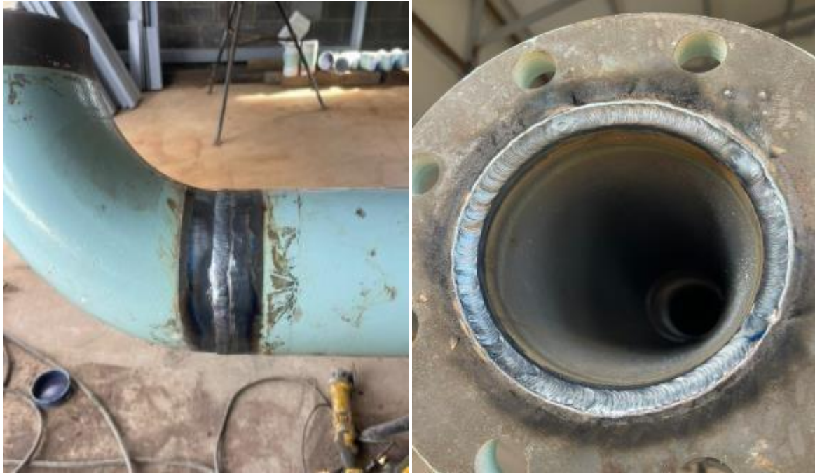
Figura 16. Presentación de soldadura con técnica GTAW.
