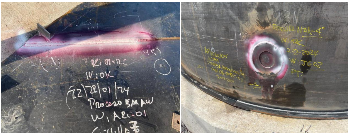
Figura 10. Inspección de soldaduras según norma NTC ISO 5817.
