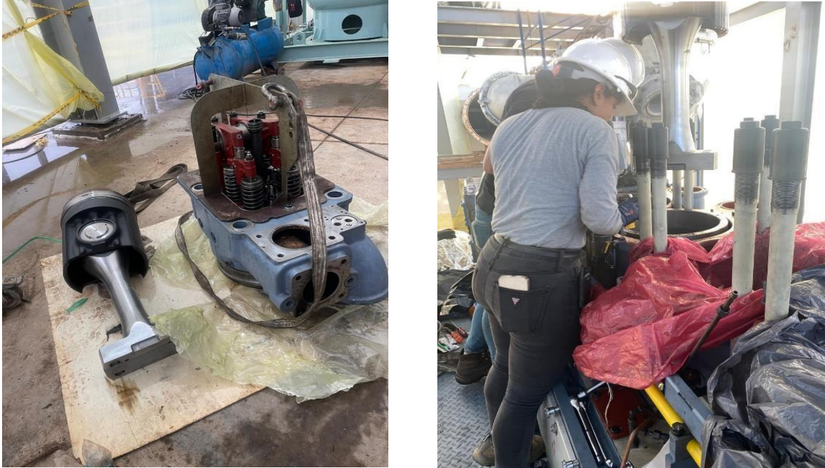
Figura 23. Armado e instalación de componentes del motor.
