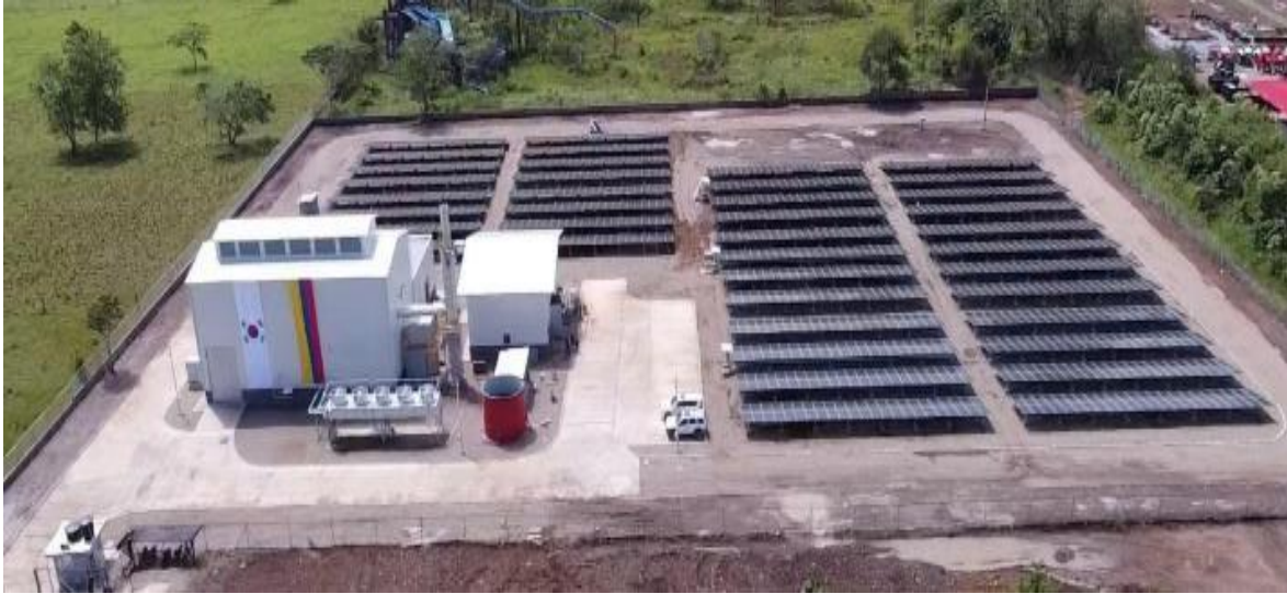
Figura 29. “Hybrid Power Plant” finalizada.
