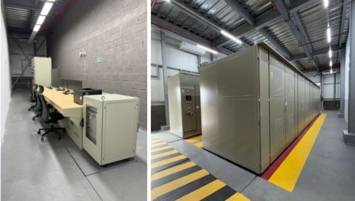
Figura 27. Cuarto de control y cuarto de celdas eléctricas finalizados.
