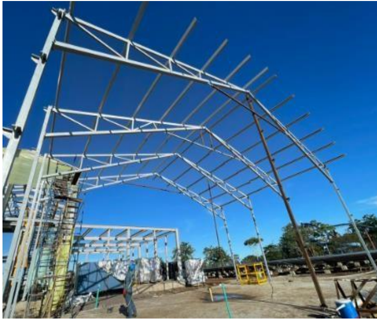
Anexo UU. Supervisión de instalación estructura metálica power house.
