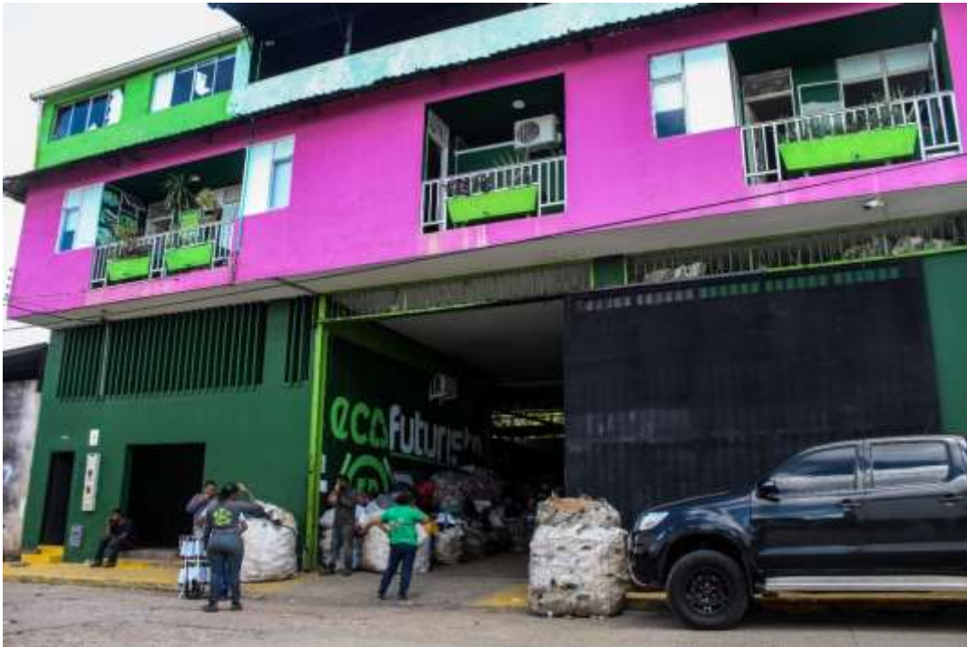
Ilustración 3. Vista posterior de la fachada de ECOFUTURISTA SAS
