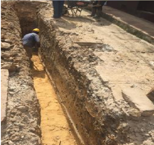
Imagen 62. Atrake de alcantarillado.
