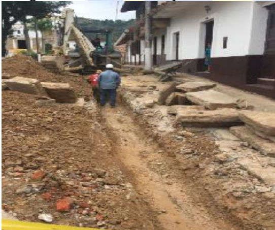
Imagen 64. Relleno zanja.
