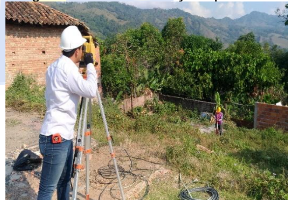
Imagen 18. Trazado y replanteo.
