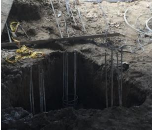
Imagen 37. Excavacion dados.
