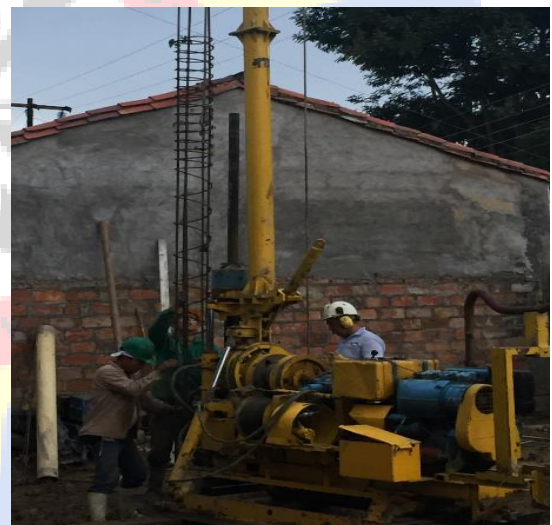
Imagen 32. Izado acero pilotes.
