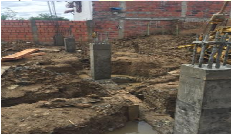
Imagen 52. Columna en concreto.
