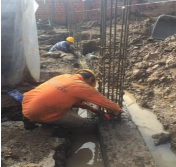
Imagen 50. Acero figurado columna.
