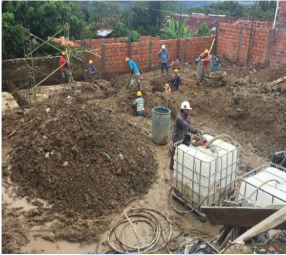
Imagen 45. Excavacion vigas de amarre.
