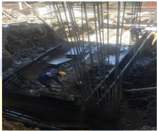
Imagen 56.Fundida placa fondo tanque
