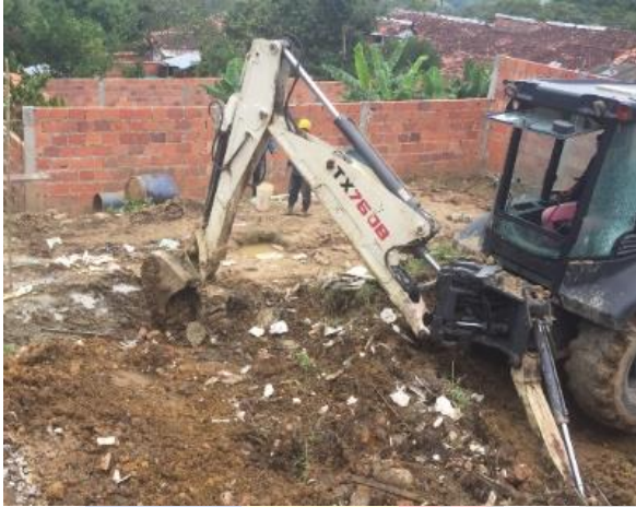
Imagen 23. Acarreo y retiro de material.
