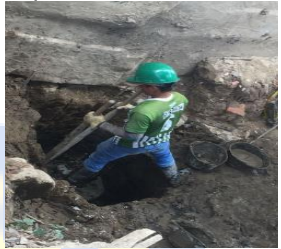
Imagen 38. Excavacion dados.
