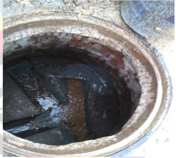
Imagen 67. Conexión a pozo.
