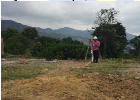
Imagen 17. Trazado y replanteo.
