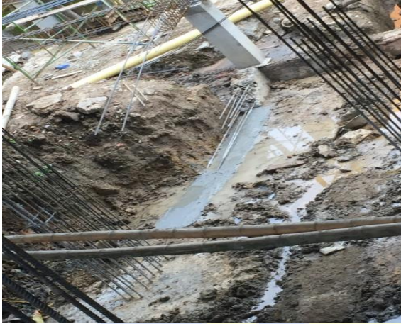
Imagen 55.Acero figurado vigas.
