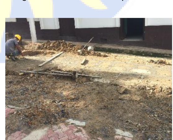
Imagen 65. Instalacion de piedra.
