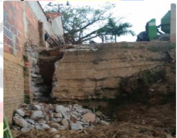
Imagen 22. Muro de contención.
