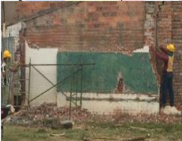
Imagen 21. Muro lateral izquierdo.
