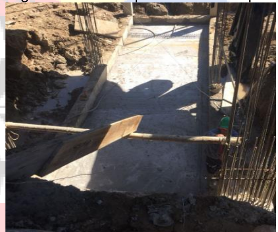
Imagen 58.Acero figurado tanque.
