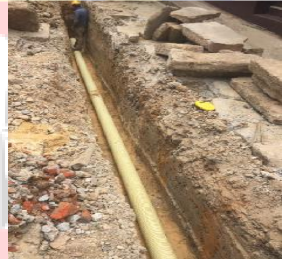
Imagen 63. Instalacion tuberia 8" conexión
