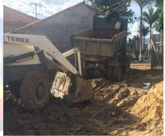
Imagen 24. Acarreo y retiro de material.
