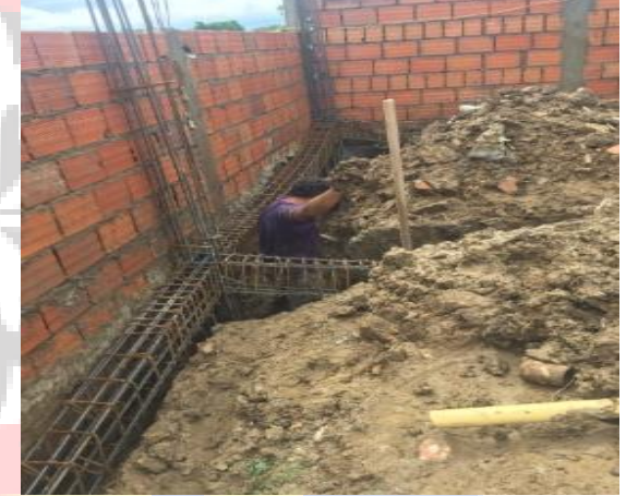
Imagen 48. Armado de acero.
