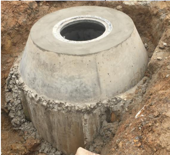
Imagen 66. Pozo de inspeccion.
