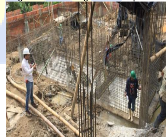
Imagen 58.Acero figurado tanque.
