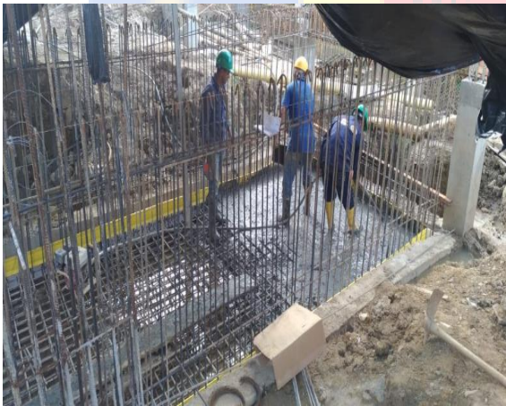
Imagen 57.Formaleta vigas tanque.
