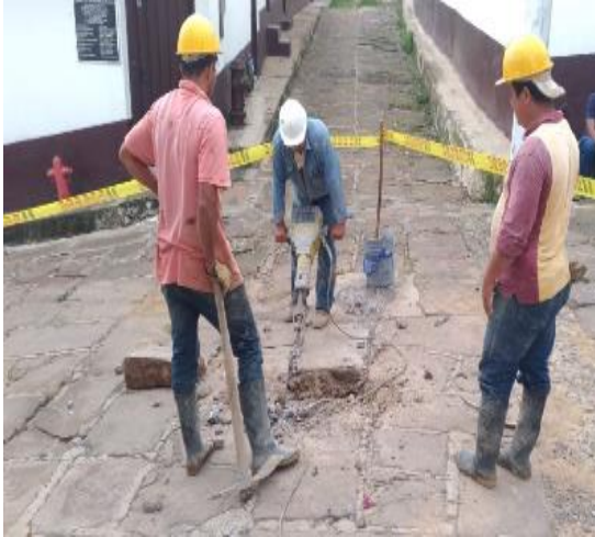
Imagen 62. Atrake de alcantarillado.
