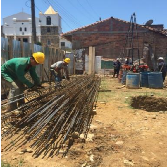
Imagen 33. Figurado de acero.
