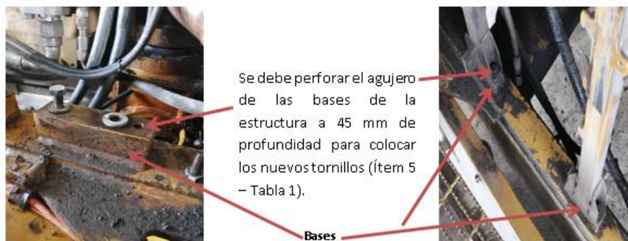
Figura 26 Bases de la estructura
