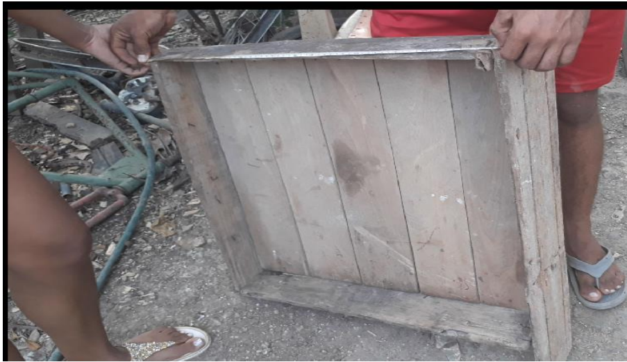
Ilustración 11. Construcción de la base u hornilla, registro fotográfico propio 2020
