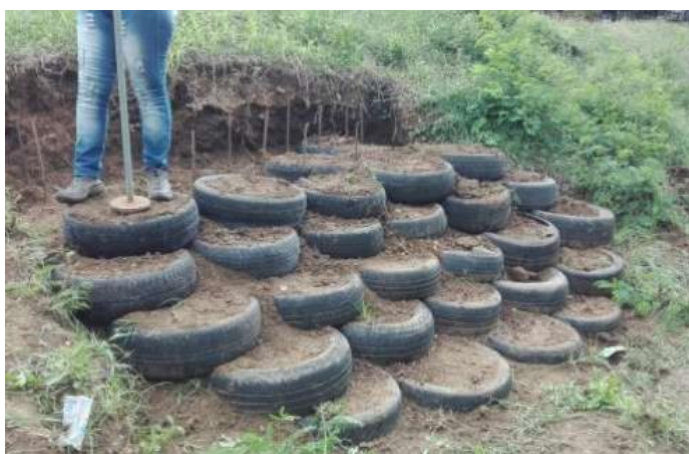
Ilustración 13. Muro de Gravedad con Llantas
