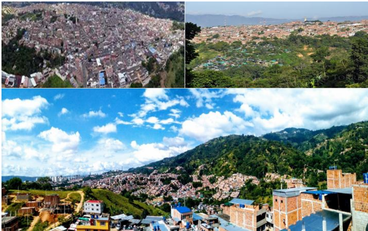
Figura 1. Vista Panorámica del Barrio La Cumbre Floridablanca.
