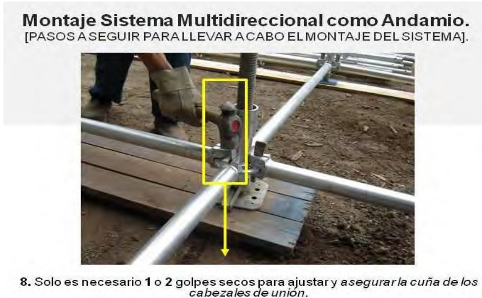
Figura 11. Pasos iniciales armado
