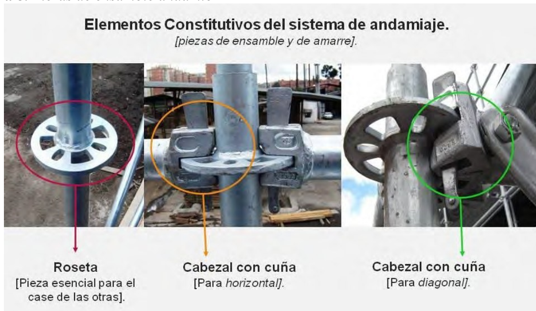
Figura 8. Piezas de ensamble andamio
