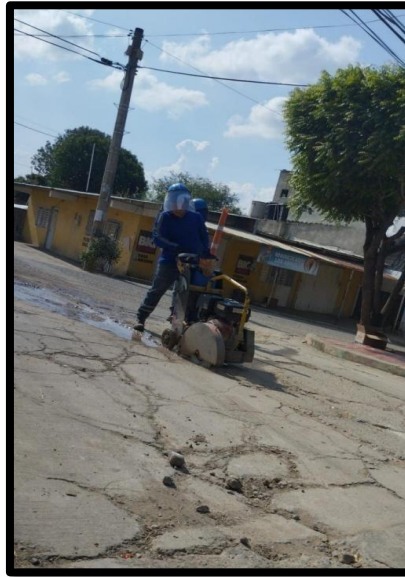
Figura 30. Uso de EPP correcto en Corte de concreto.
