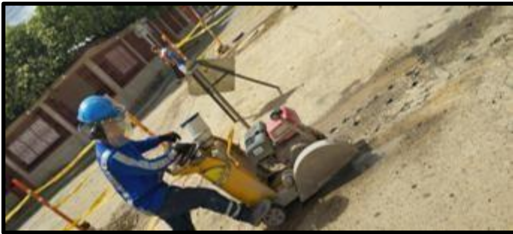
Figura 14. Corte de via en concreto
