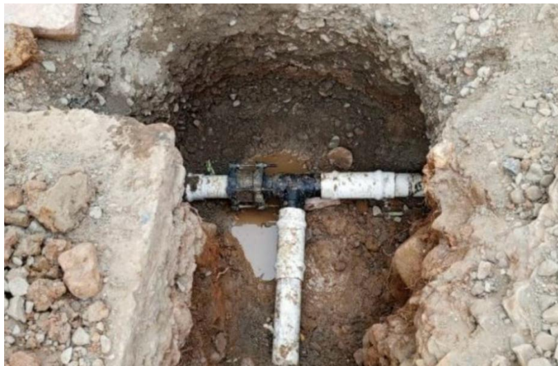
Figura 24. Accesorios de empalmes en obra del detalle 1.
