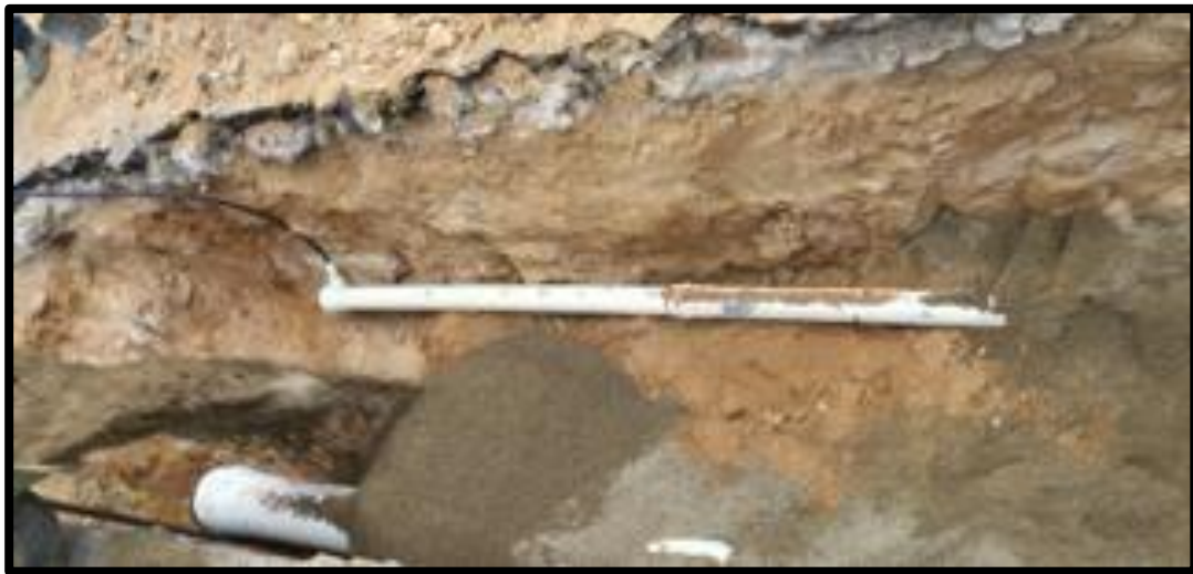
Figura 11. Tubería instalada de 3" PVC acueducto.
