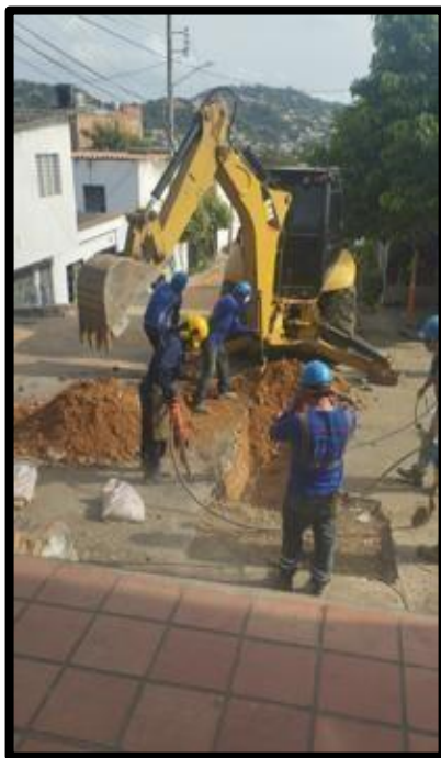
Figura 12. Excavación con máquina para realizar un pre-empalme.
