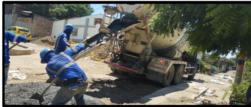
Figura 1G. Recuperación de la vía con concreto de 3000 PSI 7 días 3/4" c pgl de Normix, barrio chapinero.
