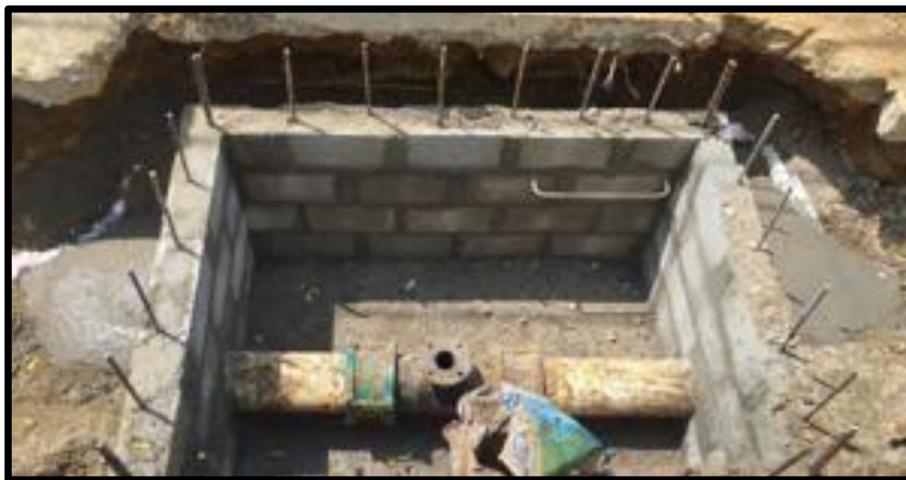
Figura 8. Construcción caja para válvula y ventosa.
