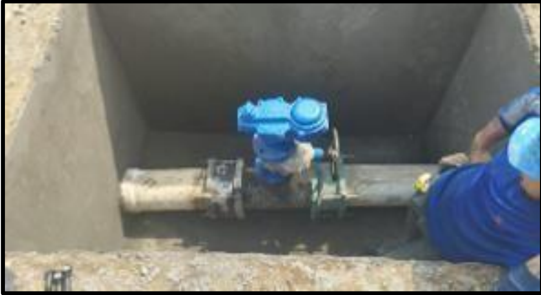
Figura 7. Empañetado caja de inspección válvula y ventosa.
