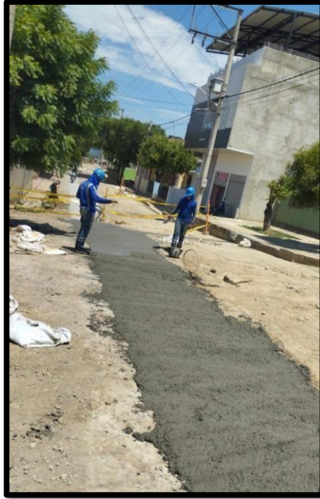
Figura 20. Recuperación de la vía con concreto de 3000 PSI 7 días 3/4" 6 pgl de Normix, barrio Carlos Ramírez Paris.
