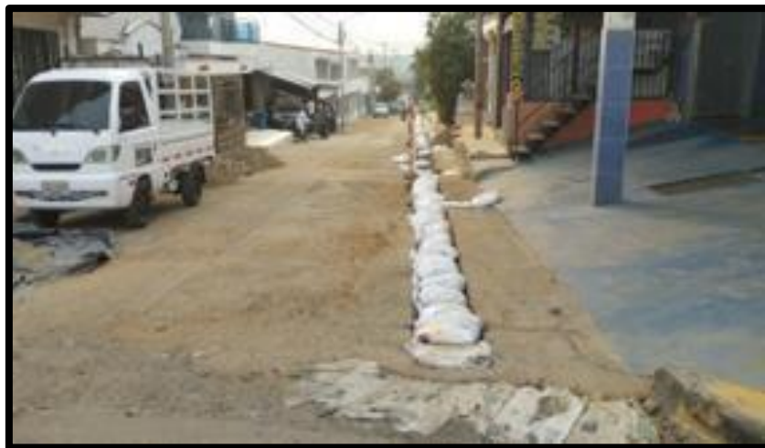
Figura 5. Zanja protegida para ser recuperada.
