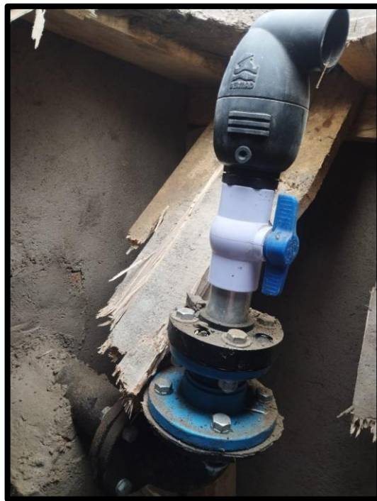
Figura 21. Construcción de ventosa de 2".
