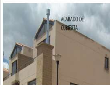
VISTA DE FACHADA PRINCIPAL CON ACABADO DE CUBIERTA
