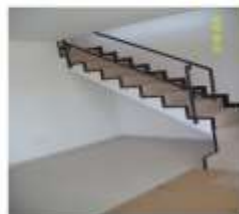
CORREDOR - ESCALERAS ACCESO SEGUNDO PISO
