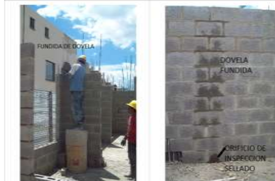
FUNDIDA DE DOVELAS
