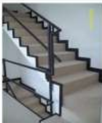
ESCALERAS ACCESO TERCER PISO
