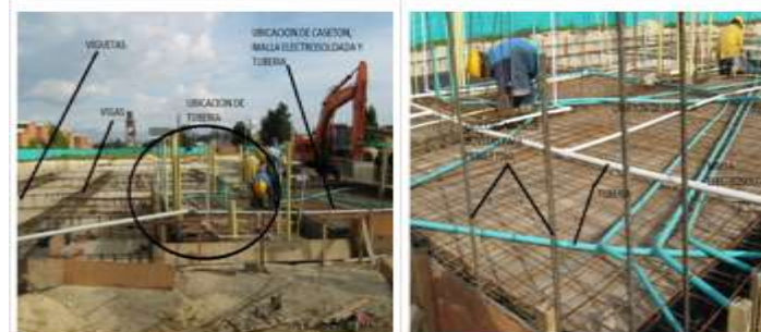
CIMENTACIÓN UBICACIÓN DE ALIGERAMIENTO ENTRE VIGAS, TENDIDO DE MALLA ELECTROSOLDADA Y TUBERÍA
