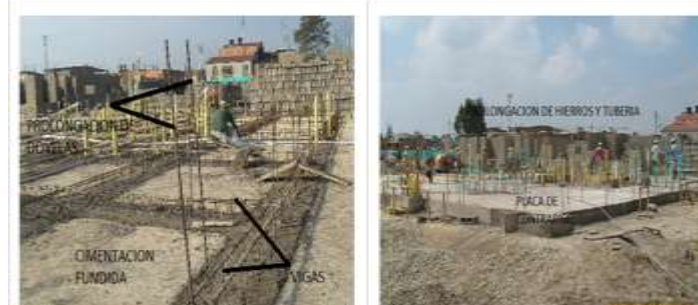
FUNDIDA DE CIMENTACIÓN Y PLACA DE CONTRAPISO
