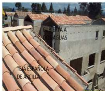
ACABADO DE CUBIERTA A DOS AGUAS EN TEJA TIPO ESPAÑOLA EN ARCILLA
