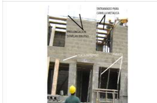
FACHADA PRINCIPAL PRIMERO Y SEGUNDO PISO
