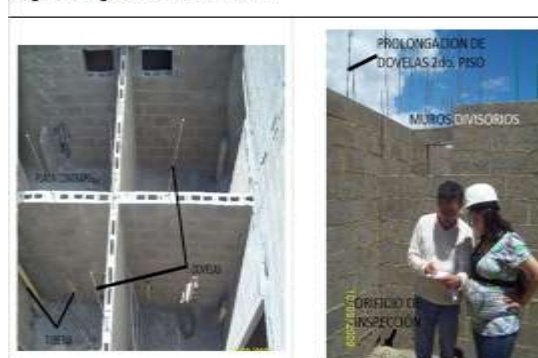
VISTA EN PLANTA DE MUROS Y DOVELAS
