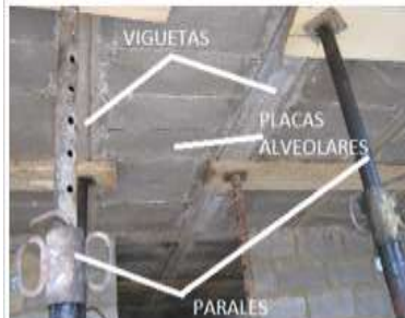
VISTA BAJO PLACA DE ENTREPISO
