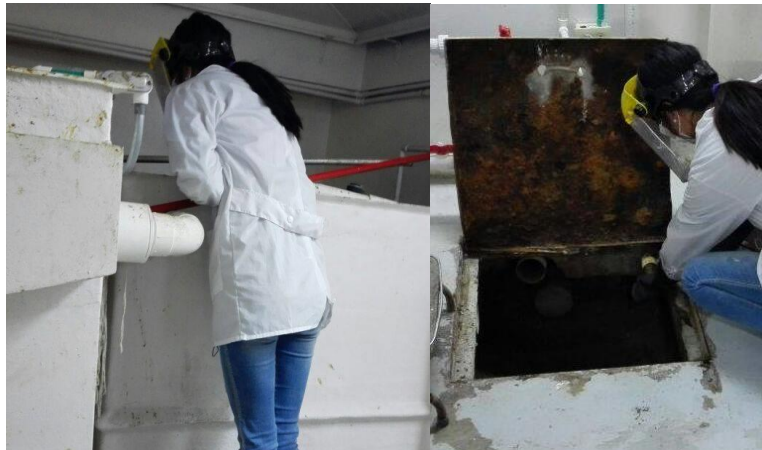
Imagen 12: Toma de muestras en el tanque de almacenamiento de agua residual y caja de inspección de salida de la PTAR.
