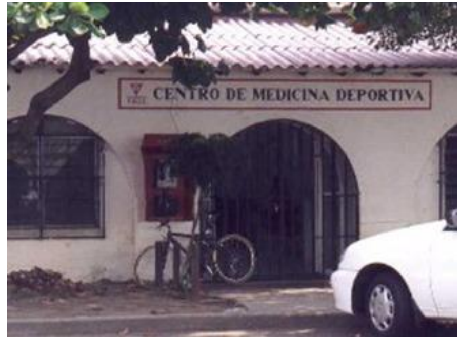
Fachada del Centro de Medicina Deportiva/Valle del Cauca-Santiago de Cali.
