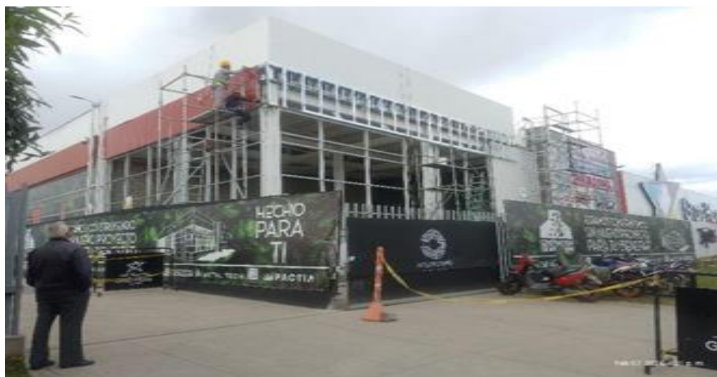
Figura 20. Instalación de estructura para superboard y detalles finales, Proyecto “GRAN PLAZA IPIALES”
