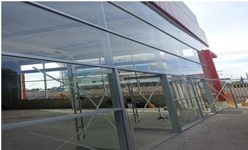
Figura 21. Obra en estructura metálica finalizada, Proyecto: “GRAN PLAZA IPIALES”
