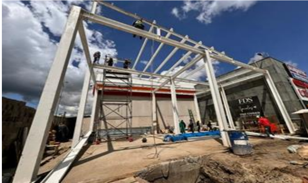
Figura 19. Izaje de la estructura, Proyecto: “GRAN PLAZA IPIALES”
