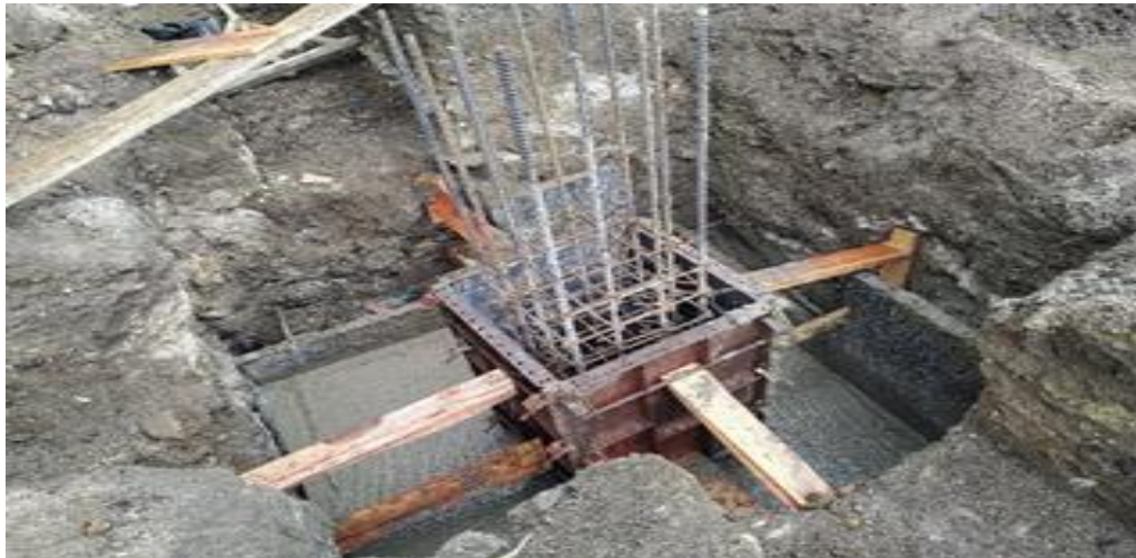
Figura 16. Fundición de zapata y pedestal, Proyecto: “GRAN PLAZA IPIALES”
