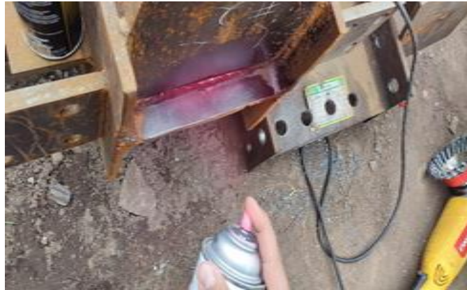
Figura 17. Pruebas de tinta en taller para estructura metálica, Proyecto “GRAN PLAZA IPIALES”
