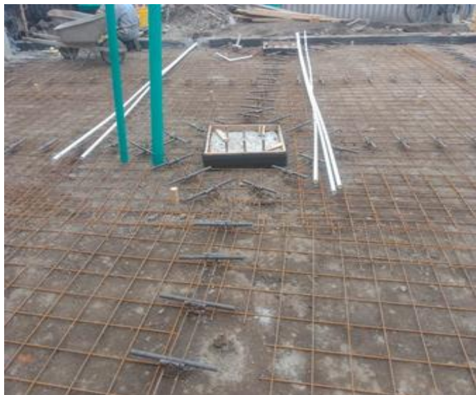
Figura 18. Acometidas y refuerzo para losa de contrapiso, Proyecto “GRAN PLAZA IPIALES”
