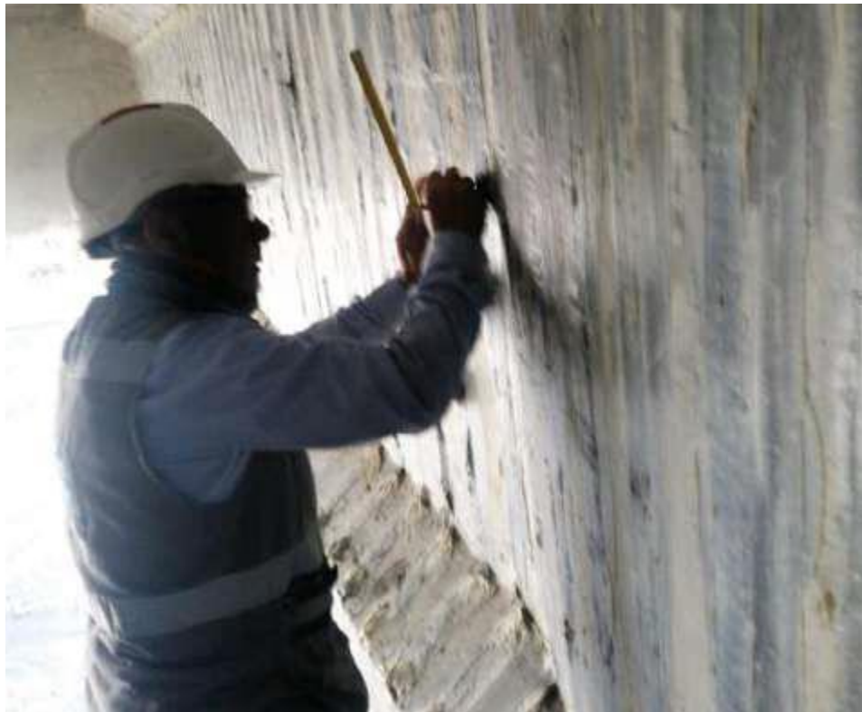
Figura 9. Ensayo de Potencial de Corrosión
