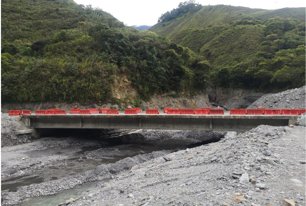
Figura 6. Fotografía Puente “Estaquecá”
