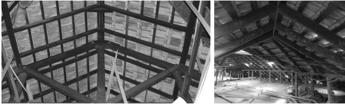
Figuras 53 y 54: Vista interna de cubiertas en tejas. Cubierta en teja de cemento a dos aguas del Antiguo Colegio de Barranquilla para Varones, CODEBA 7 y crujías en el Hotel El Prado. Fuentes: Elaboración propia.
