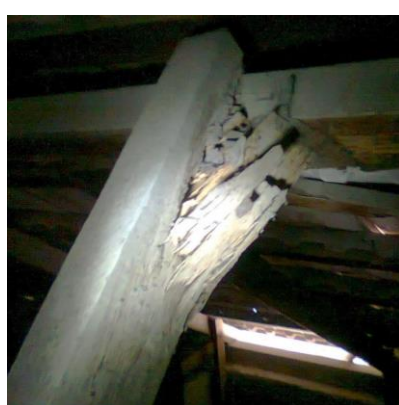
Figuras 83, 84 y 85: Cubierta y cielo raso. Sistema constructivo de cubierta es propio de la ciudad a finales de los años 1930 y hasta la década de los 60's cuando se reemplazó por losas de hormigón macizas. Fuente: Elaboración propia.
