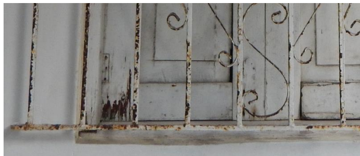
Figuras 78 y 79: Erosión y oxidación. Erosión mecánica por desgaste en plantilla de piso, oxidación previa en rejas en hierro forjado de fachada principal. Fuente: Elaboración propia.
