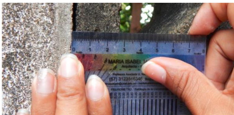
Figuras 95 y 96: Desprendimientos y aplastamientos. Detalle de desprendimiento de calados de muro divisorio de patios y estado de muro en área de labores. Fuente: Elaboración propia.
