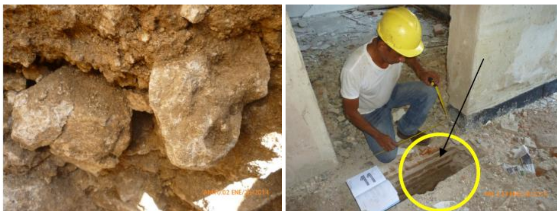
Figuras 43 y 44: Hallazgos de exploración. Piedra caliza utilizada en la cimentación y viga de arriostra en ladrillo de arcilla cocida. Fuente: (Barraza, 2014).
