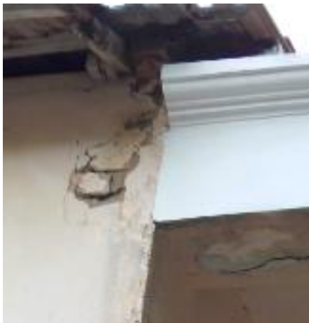
Figuras 64 y 65: Grietas y cala estratigráfica. Se evidencian las grietas por falla mecánica en unión viga de losa y muro a nivel de fachada principal; así como cala estratigráfica en muro exterior de la vivienda donde se aprecian las dimensiones del ladrillo en arcilla cocida, que es la pieza de mampostería del inmueble. Fuente: Elaboración propia.
