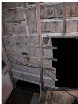
Figuras 83, 84 y 85: Cubierta y cielo raso. Sistema constructivo de cubierta es propio de la ciudad a finales de los años 1930 y hasta la década de los 60's cuando se reemplazó por losas de hormigón macizas. Fuente: Elaboración propia.
