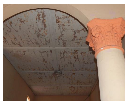
Figuras 83, 84 y 85: Cubierta y cielo raso. Sistema constructivo de cubierta es propio de la ciudad a finales de los años 1930 y hasta la década de los 60's cuando se reemplazó por losas de hormigón macizas. Fuente: Elaboración propia.
