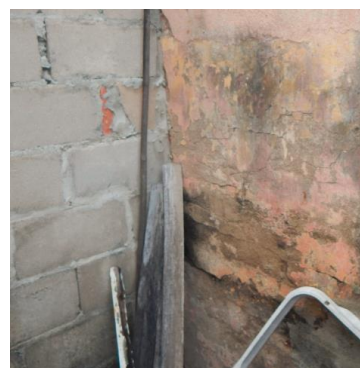
Figuras 95 y 96: Desprendimientos y aplastamientos. Detalle de desprendimiento de calados de muro divisorio de patios y estado de muro en área de labores. Fuente: Elaboración propia.
