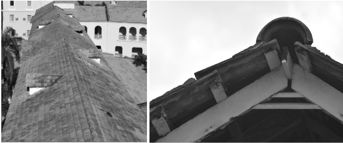
Figuras 50 y 51: Cubierta en teja de cemento. Hotel El Prado, Barranquilla. Fuente:(Rojas, 2017).
