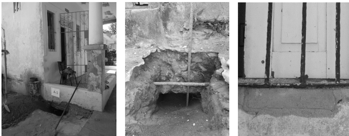
Figuras 108, 109 y 110: Apiques 1 y 2 y cala profunda. Fuente. Elaboración propia.
