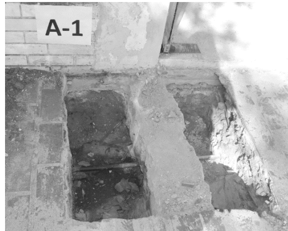
Figuras 20 y 21: Muros y apiques. Estado de muros laterales perimetrales y muestra de exploración de cimientos a través de apiques. Fuente: Elaboración propia.
