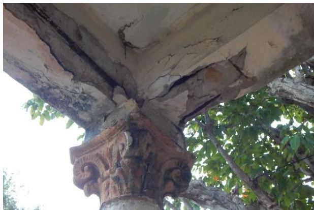
Figuras 80, 81 y 82: Carbonatación y comején. Extrusión de arriostres perimetrales en losa de fachada, se evidencia oxidación del acero de refuerzo, así como presencia de hongos, líquenes y comején en muro exterior. Fuente: Elaboración propia.
