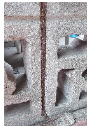
Figuras 80, 81 y 82: Carbonatación y comején. Extrusión de arriostres perimetrales en losa de fachada, se evidencia oxidación del acero de refuerzo, así como presencia de hongos, líquenes y comején en muro exterior. Fuente: Elaboración propia.
