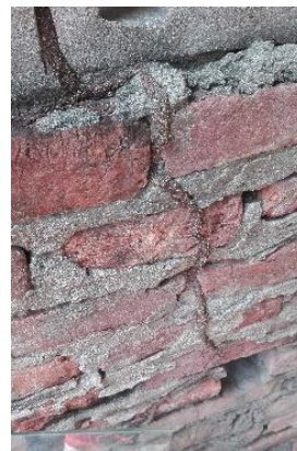
Figuras 80, 81 y 82: Carbonatación y comején. Extrusión de arriostres perimetrales en losa de fachada, se evidencia oxidación del acero de refuerzo, así como presencia de hongos, líquenes y comején en muro exterior. Fuente: Elaboración propia.
