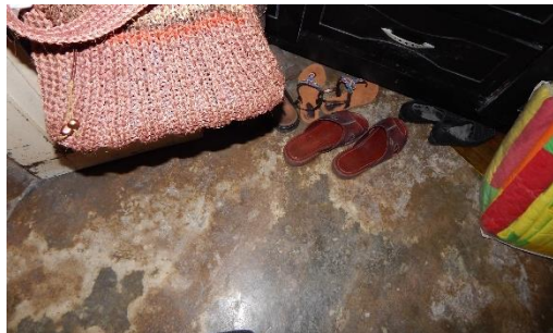
Figuras 78 y 79: Erosión y oxidación. Erosión mecánica por desgaste en plantilla de piso, oxidación previa en rejas en hierro forjado de fachada principal. Fuente: Elaboración propia.
