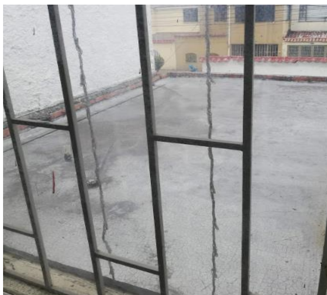
Fotografía 3. Terreno para construcción.
