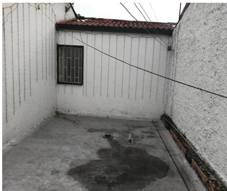
Fotografía 4. Terreno para la construcción.
