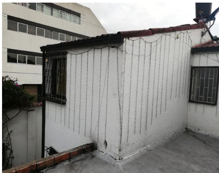
Fotografía 5. Terreno para la construcción
