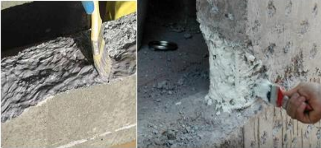
Ilustración 41 Puente de adherencia.
