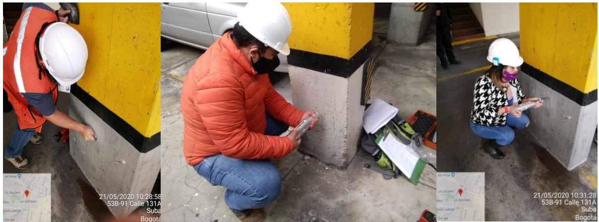
Ilustración 36 Preparación de la superficie y realización del ensayo.
