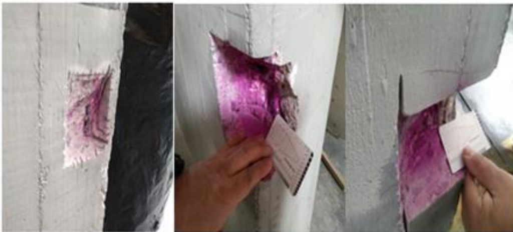
Ilustración 37 Apique realizado para hacer prueba de carbonatación.
