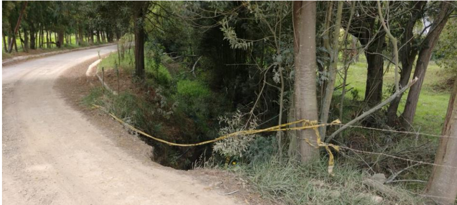
Ilustración 12 - Estado actual de la estructura a intervenir.
