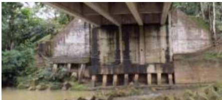
Figura 25. Recalce del estribo con micropilotes
