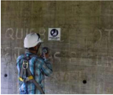
Figura 17. Mapeo del acero de refuerzo
