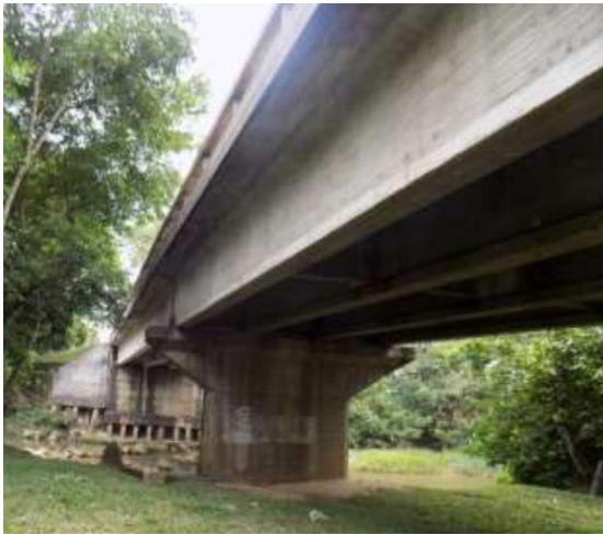
Figura 6. Vista longitudinal del puente
