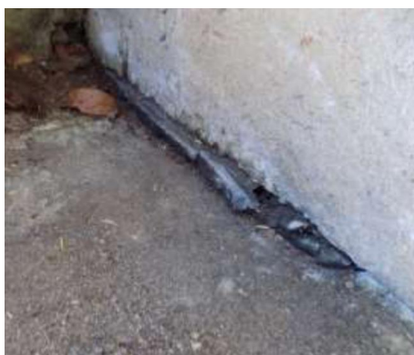
Figura 21. Aplastamiento de neopreno
