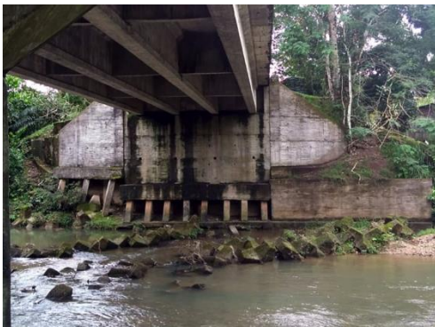
Figura 9. Hexápodos en concreto en el estribo izquierdo
