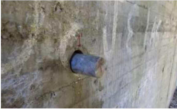
Figura 20. Extracción de núcleos en el estribo
