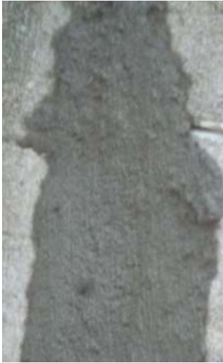
Figura 19. Reparación de regatas
