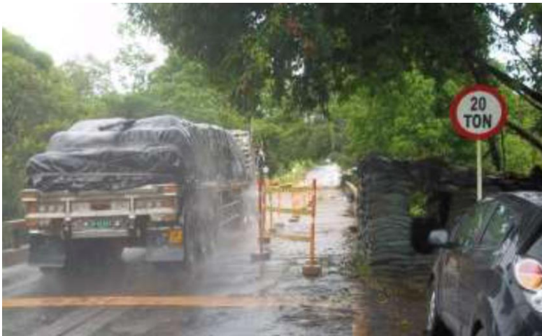
Figura 7. Restricción de carga en el puente
