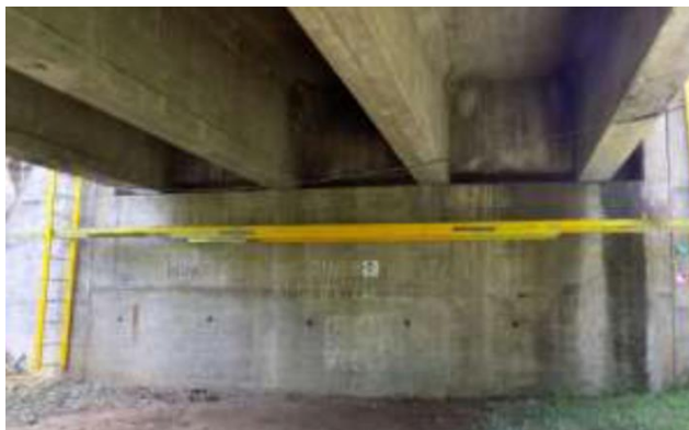
Figura 26. Estribo derecho no presenta socavación
