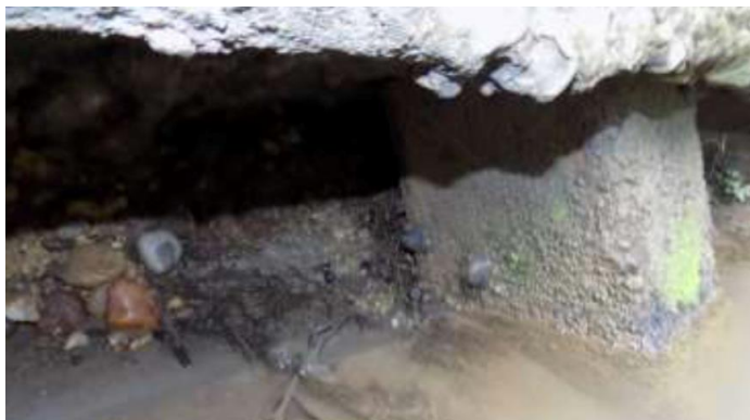
Figura 27. Parte inferior de pila con apoyo sobre micropilotes
