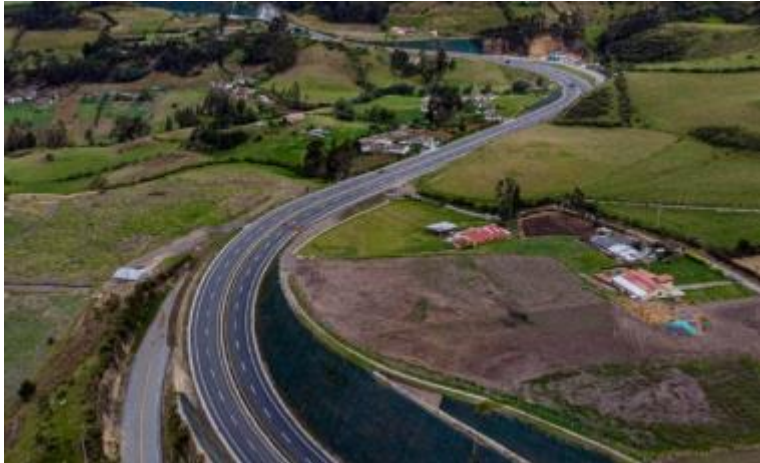
Figura 2. Mejoramiento de vía en Colombia
