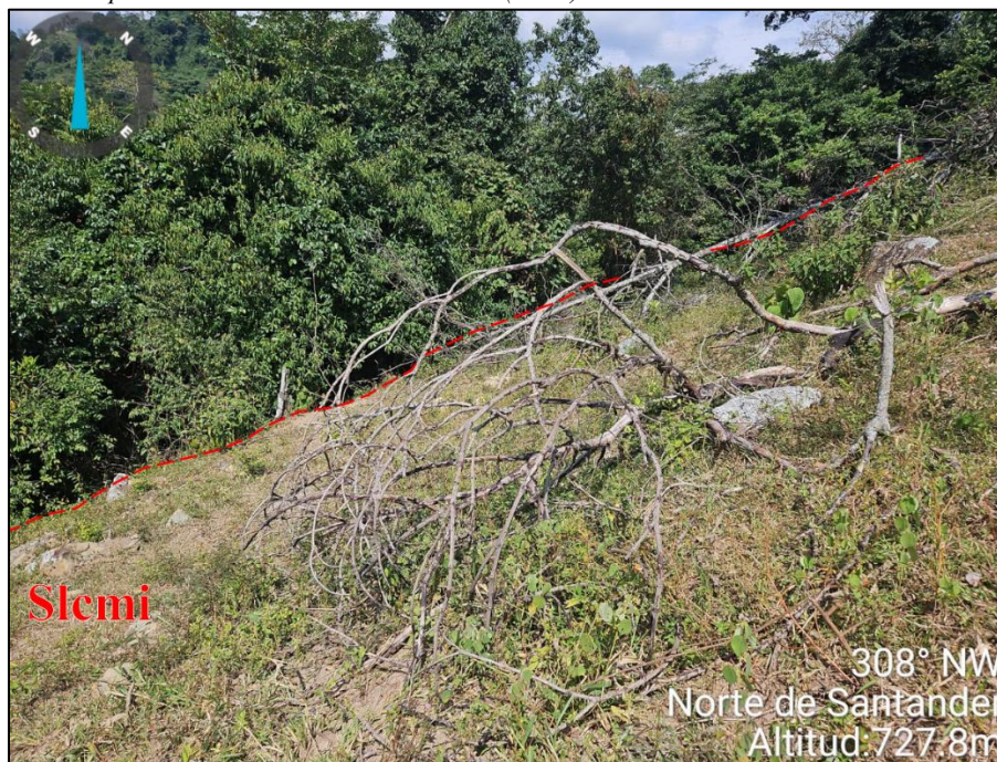
Figura 5. Ladera de contrapendiente moderadamente inclinada (Slc mi )
