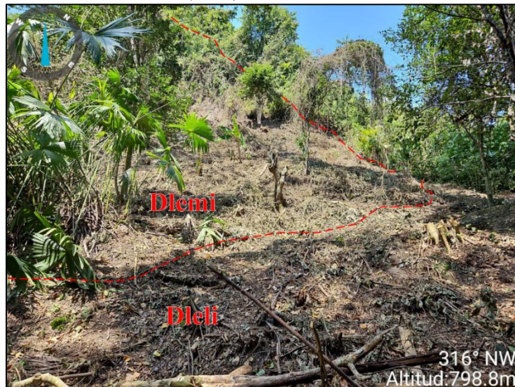
Figura 19. Ladera erosiva moderadamente inclinada (Dlemi)
