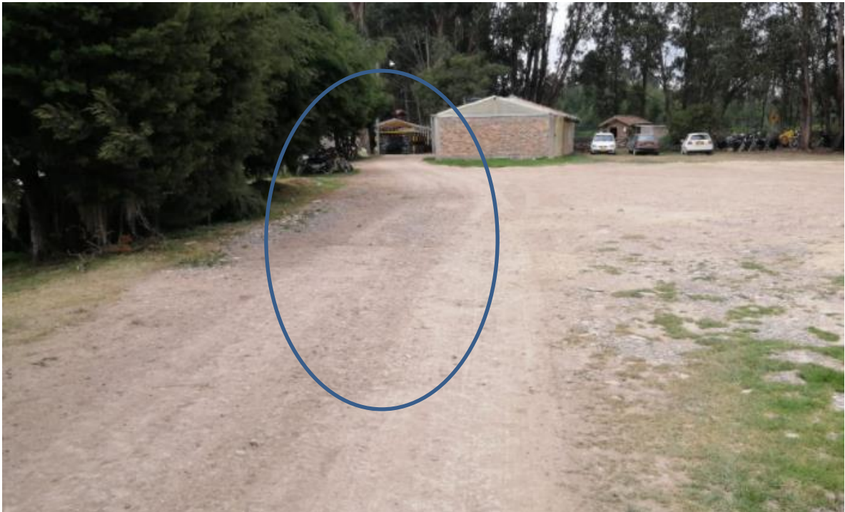
Fotografía 99. Tramo 2 de prueba.
