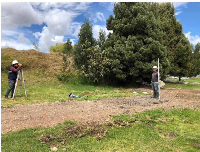
Fotografía 36. Nivelación del tramo de prueba 1.
