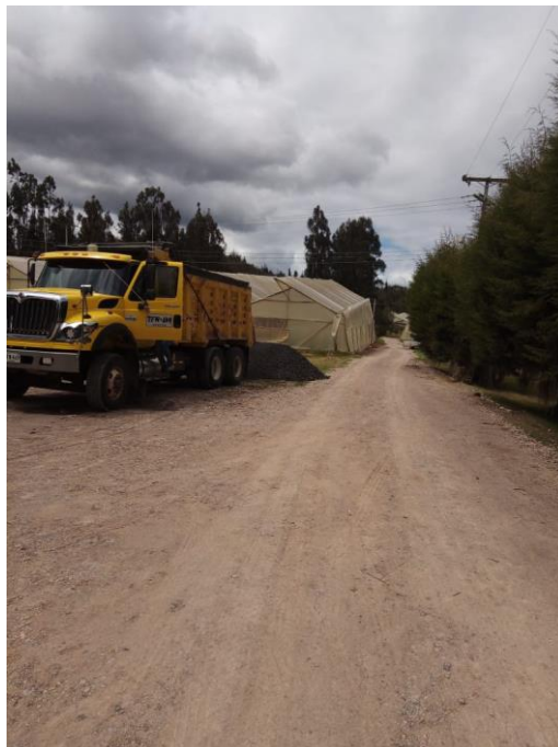
Fotografía 66. Descarga de la escoria de Gerdau Diaco en el tramo de prueba 2.
