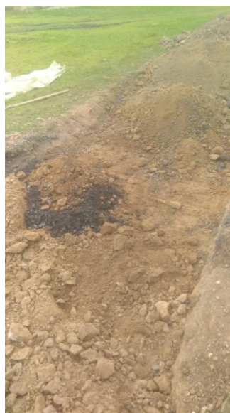
Fotografía 44. Excavación y mezcla del suelo extraído con la escoria de acería en el tramo de prueba 1.
