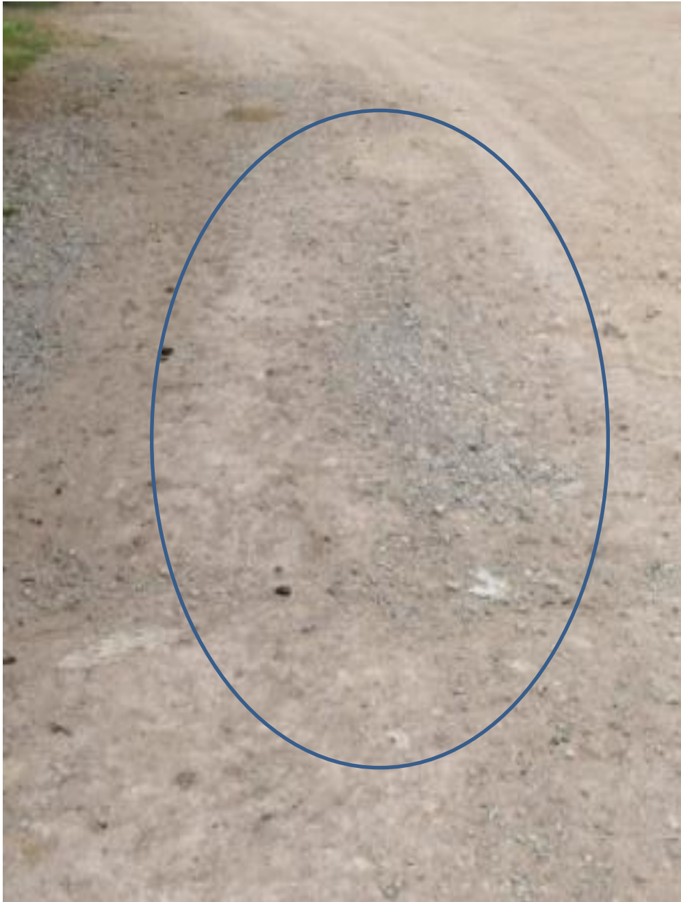
Fotografía 98. Tramo 2 de prueba.
