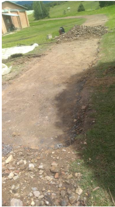
Fotografía 53. Proceso de compactación del terreno en el tramo de prueba 1.
