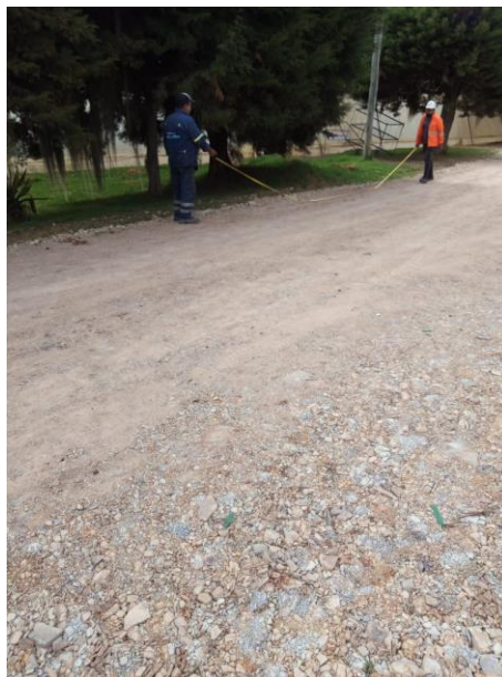
Fotografía 70. Abscisado del tramo de prueba 2.
