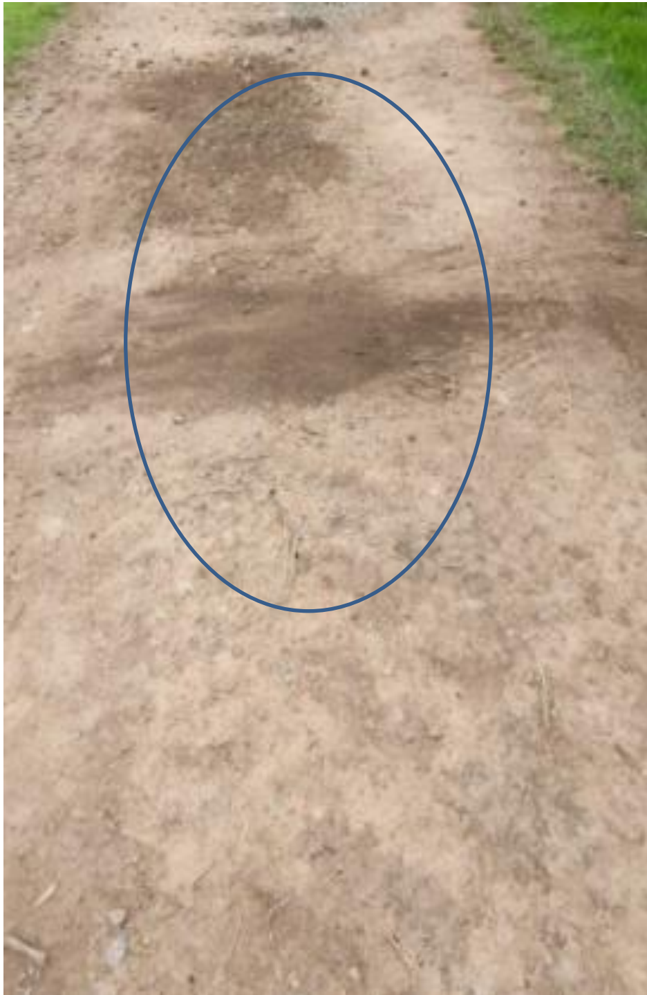
Fotografía 97. Tramo 1 de prueba.
