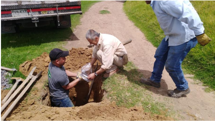
Fotografía 41. Toma de muestras en el tramo de prueba 1, vías de acceso a Flores el Futuro, en el Municipio de Nemocón – Cundinamarca.
