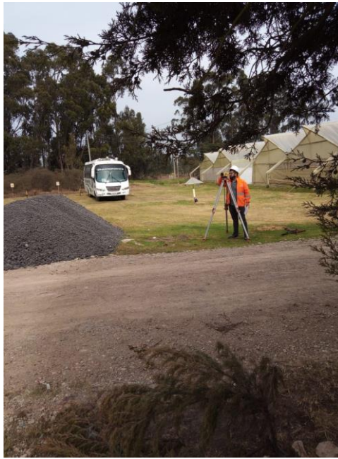
Fotografía 71. Nivelación del tramo de prueba 2.
