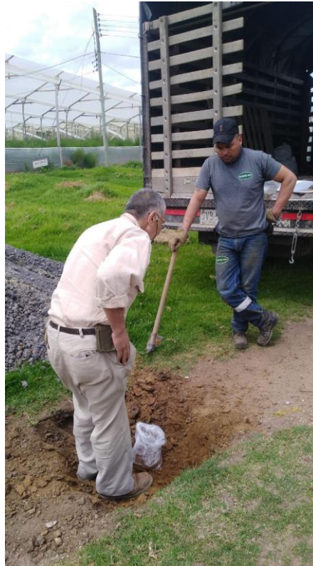
Fotografía 37. Toma de muestras en el tramo de prueba 1, vías de acceso a Flores el Futuro, en el Municipio de Nemocón – Cundinamarca.
