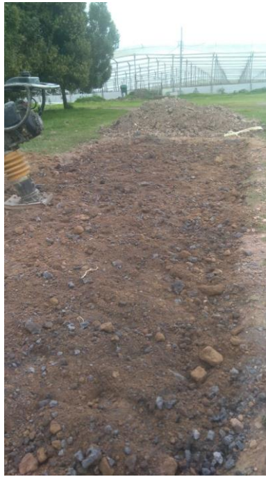
Fotografía 51. Proceso de compactación del terreno en el tramo de prueba 1.
