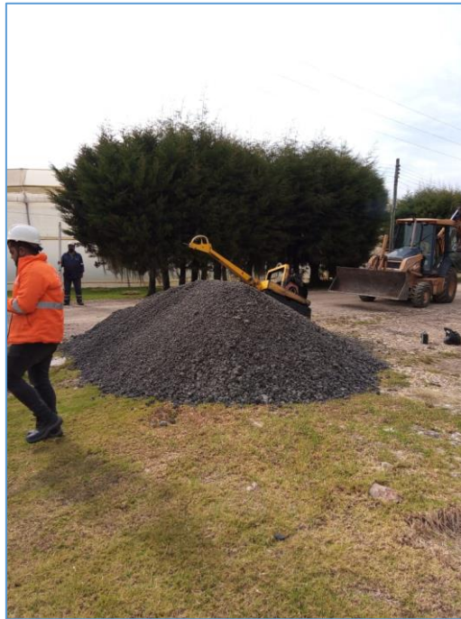
Fotografía 67. Material descargado en el sector del tramo de prueba 2.
