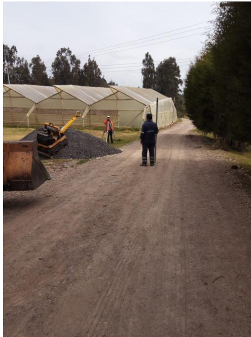
Fotografía 73. Nivelación del tramo de prueba 2.
