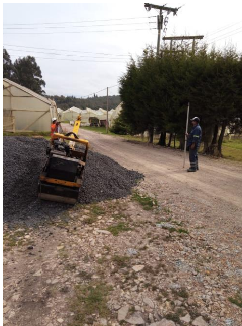
Fotografía 72. Nivelación del tramo de prueba 2.
