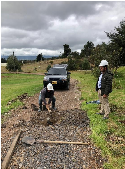
Fotografía 61. Toma de muestras en el terreno con adición de escoria en el tramo de prueba 1, muestra 2.
