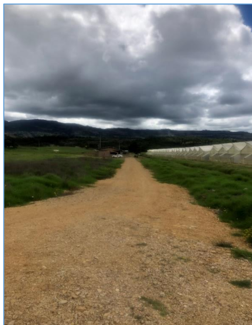
Fotografía 33. Tramo de prueba 1 en el Municipio de Nemocón, vías de acceso a Flores el Futuro.
