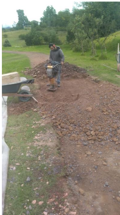
Fotografía 52. Proceso de compactación del terreno en el tramo de prueba 1.
