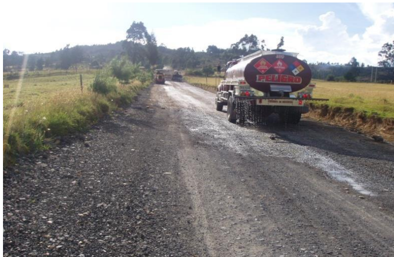
Fotografía 12. Vía intermunicipal desde tuta hacia el municipio de Toca, utilización de agregado siderúrgico a lo largo de 14 Km.
