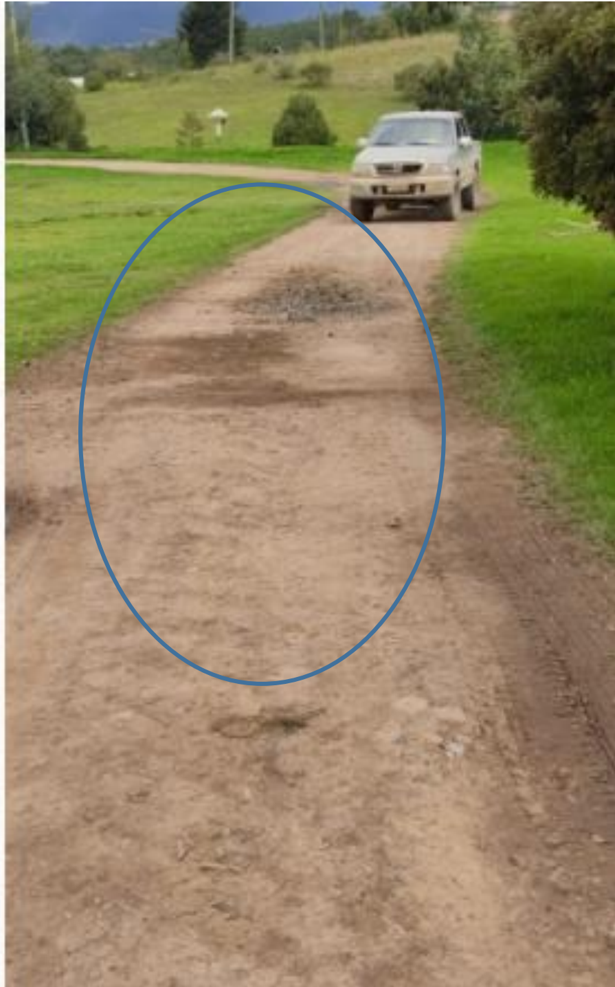
Fotografía 96. Tramo 1 de prueba.
