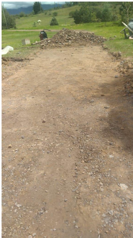
Fotografía 54. Proceso de compactación del terreno en el tramo de prueba 1.
