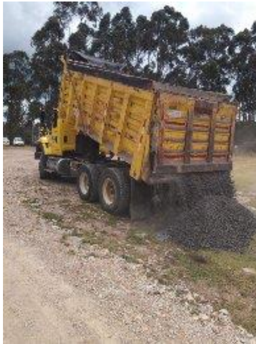
Fotografía 65. Descarga de la escoria de Gerdau Diaco en el tramo de prueba 2.
