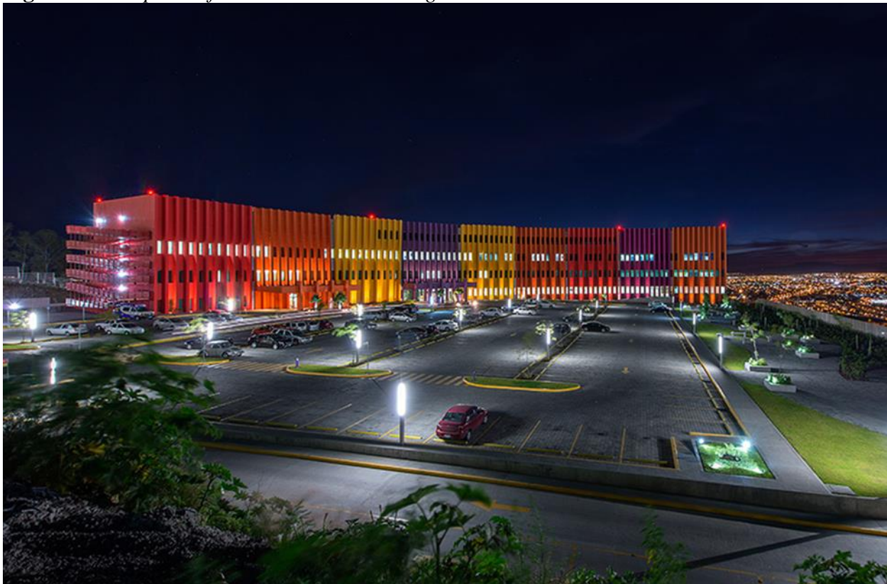
Figura 48. Hospital infantil Teletón de oncología
