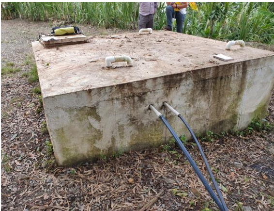
FOTOGRAFIAS 28.29: TANQUE DE ALMACENAMIENTO Y LÍNEA DE ADUCCIÓN. (FOTOGRAFÍAS DILIGENCIA DE INSPECCIÓN)-
