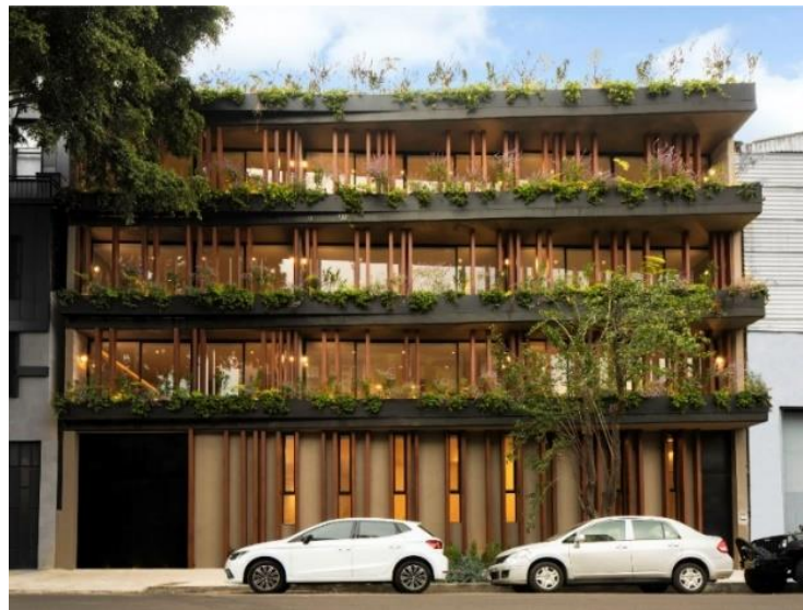
Figura 1. Fachada del edificio Cova07
