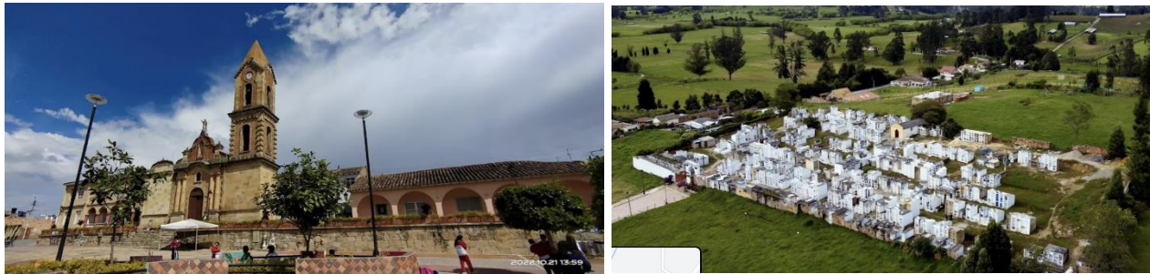
Ilustración 3. Ubicación de la Parroquia y Cementerio Santa Rita de Casia
