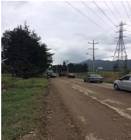
Figura 136. Tramo de la vía en el kilómetro 2,1 en dirección Siberia-Tenjo.
