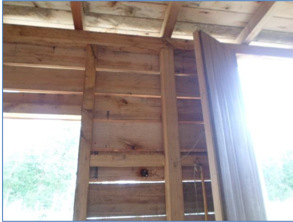
Figura 97. Dintel y montante vivienda en madera dos plantas
