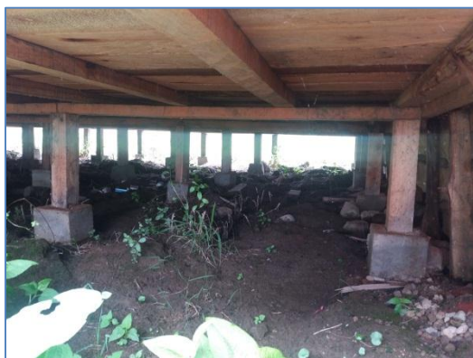
Figura 104. Cimentación en pilares elevados
