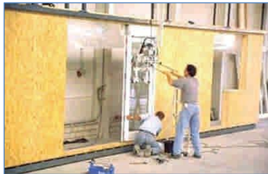
Figura 38. Instalación de una puerta a un tabique autoportante.
