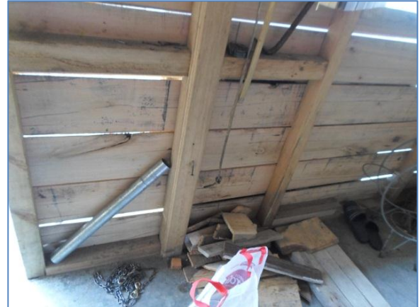
Figura 97. Dintel y montante vivienda en madera dos plantas
