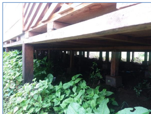
Figura 104. Cimentación en pilares elevados
