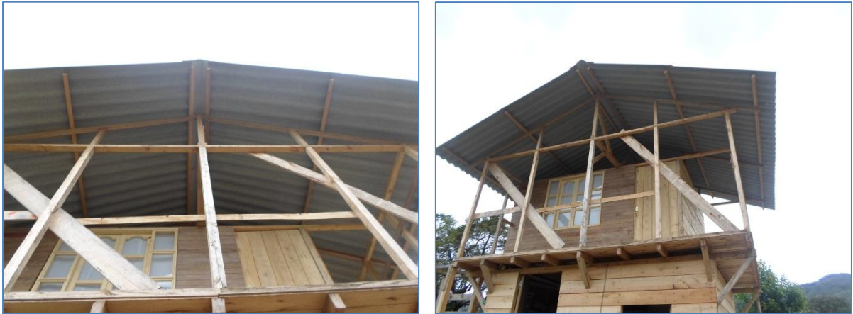
Figura 102. Sistema cubierta dos aguas asbesto cemento vivienda en madera
