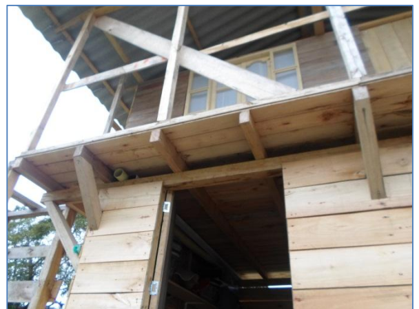
Figura 99. Vigas aéreas vivienda en madera dos plantas.
