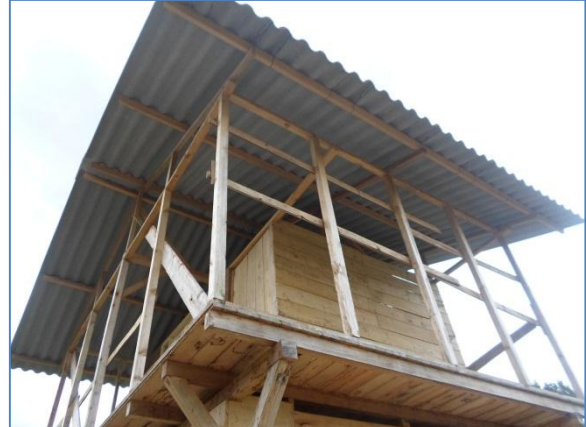
Figura 100. Arriostramiento vivienda en madera dos plantas
