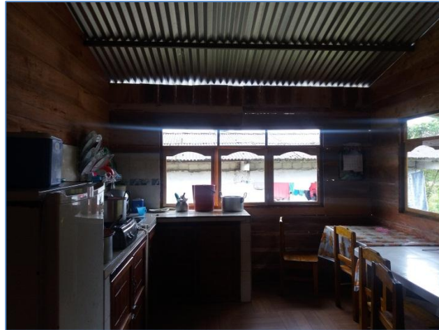
Figura 107. Cocina vivienda en madera sin suministro de agua potable.
