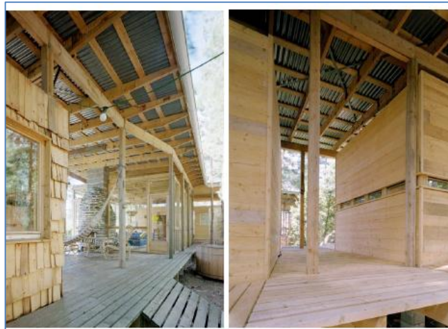
Figura 41. Sistema de poste y viga.
