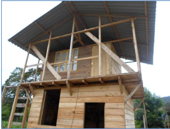
Figura 100. Arriostramiento vivienda en madera dos plantas
