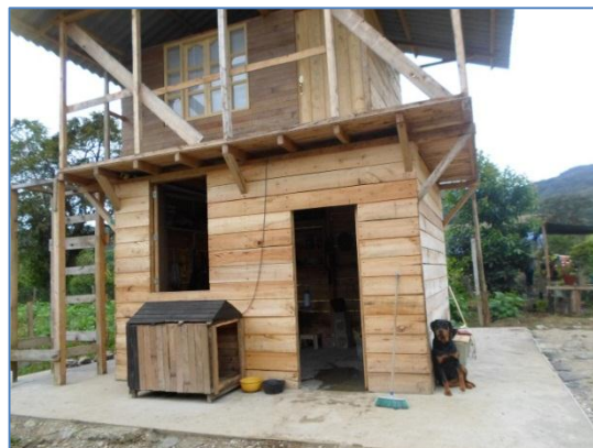
Figura 95. Sistema de entrepisos vivienda en madera
