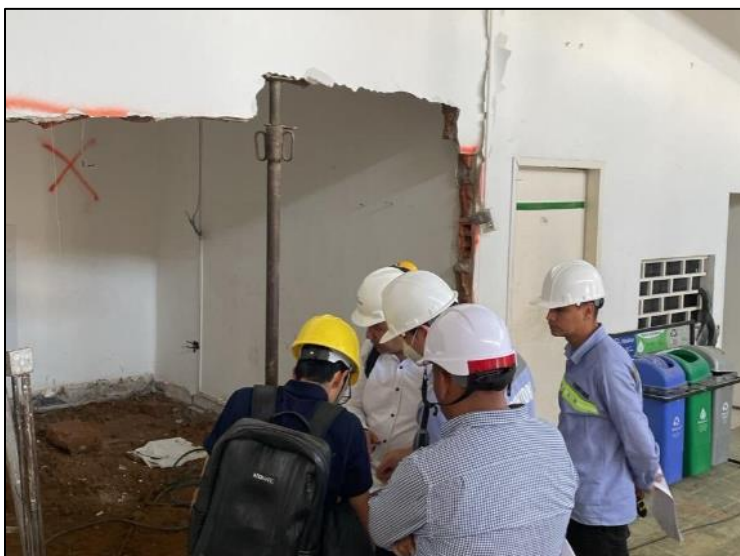
Figura 12. Visita profesional estructural. Frente Concordia
