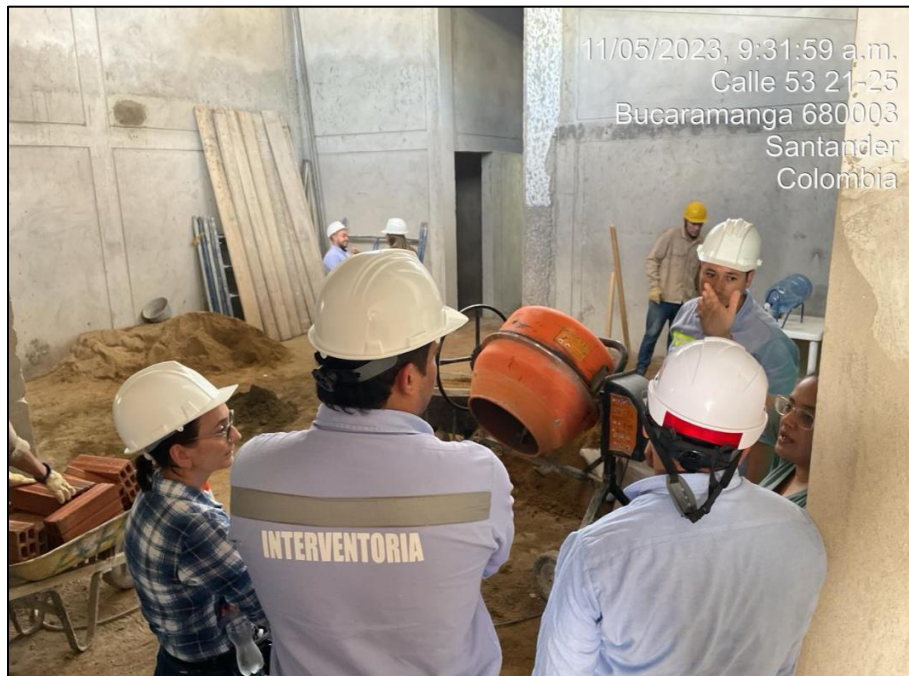
Figura 23. Visita y comité de obra salón comunal Concordia.
