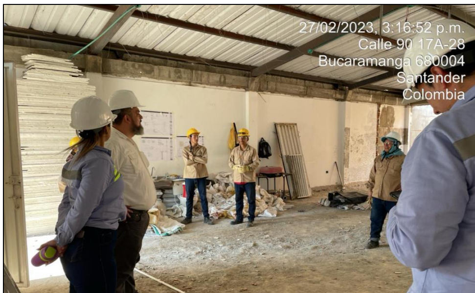
Figura 8. Verificación del cumplimiento del personal en obra. Frente San Luis.
