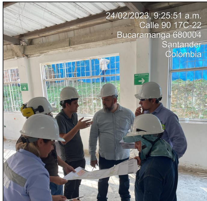
Figura 11. Visita profesional estructural y arquitectónico. Frente San Luis.
