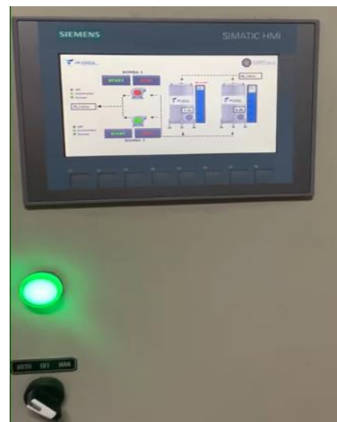
Figura 46. Bomba 2 operando en modo automático caudal de 7L/min
