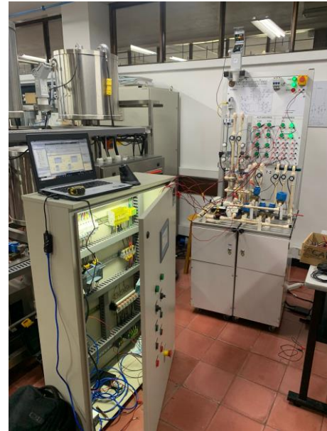
Figura 39. Conexión del banco de pruebas con el tablero
