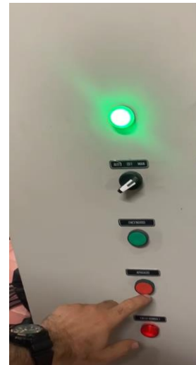
Figura 45. Bomba 1 operando con caudal de 6L/min, bomba 2 apagada
