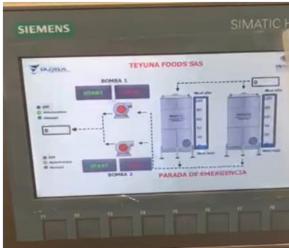
Figura 38. Parada de emergencia activada
