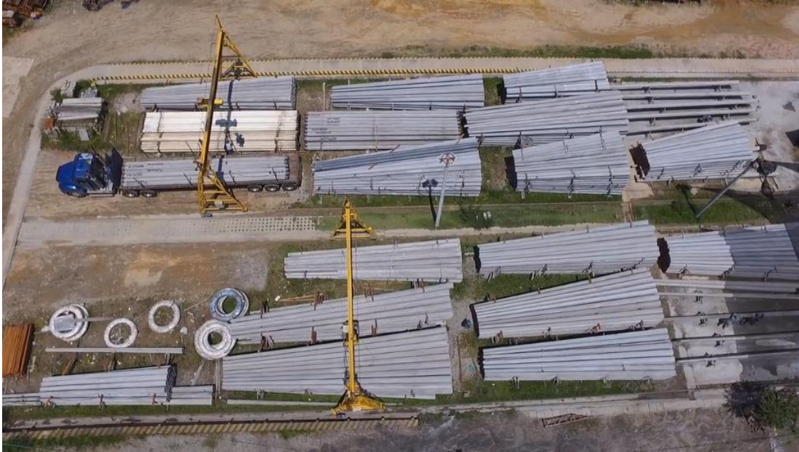
Figura 4. Zona de almacenamiento. Tomado “de Pretecor. Ltda”, 2018
