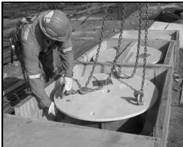
Figura 26. Izaje de los aisladores.
