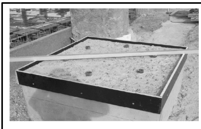
Figura 19. Vaciado del concreto en el soporte del moldaje en obra.
