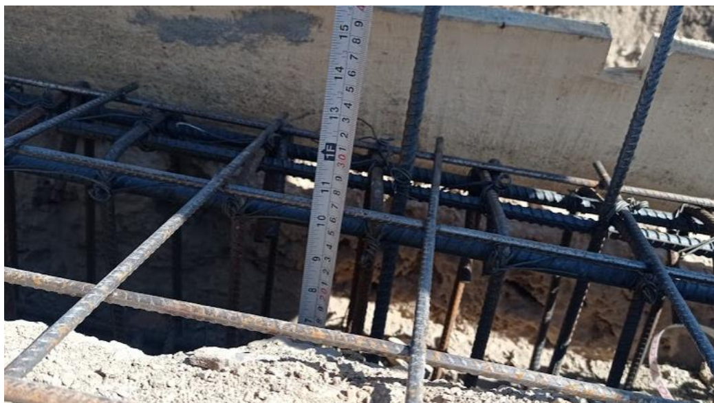
Ilustración 7 Control medidas excavación cimentación
