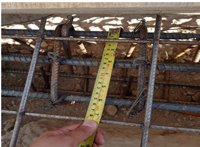
Ilustración 8 Control medidas acero cimentación
