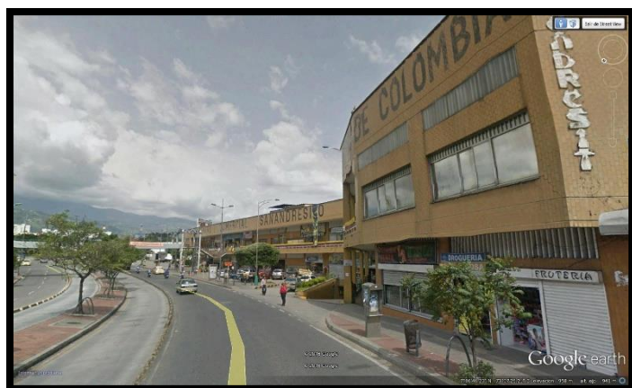
Figura 23. Centro comercial Sanandresitos – Fuente: Tomado de google Earth
